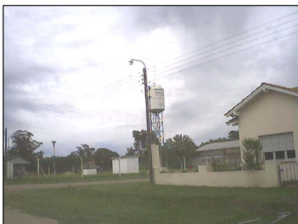
Imagen 5. Tanque de agua potable en S. Agustín.
