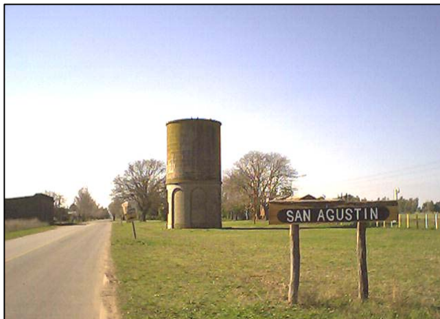
Imagen 9. Acceso sur a San Agustín. Ruta conectora 88 – 55.
