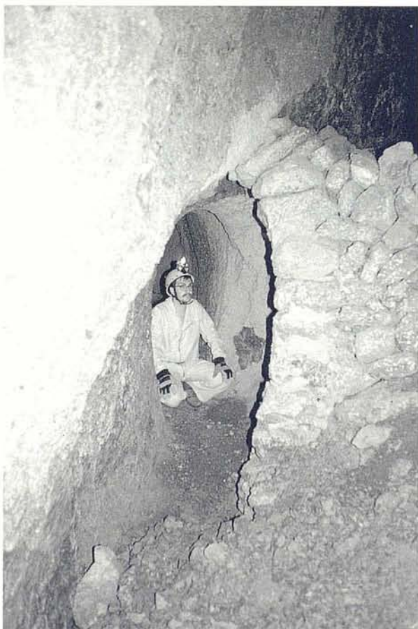
Foto 3: Inicio de galería donde se aprecia la fortificación de la misma mediante mampostería y piedras. Esta galería corresponde a la que aparece en la Fig. 3,13.
