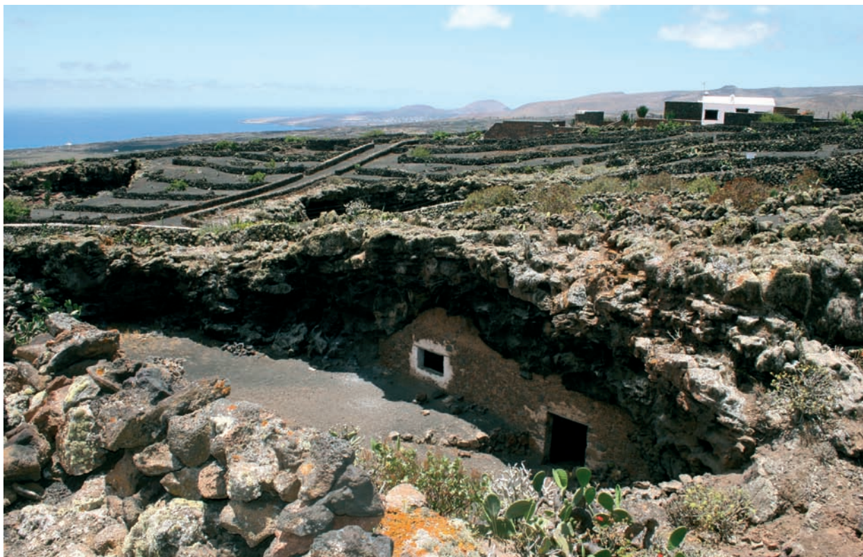
Foto 8: Entrada meridional al Jameo del Lagar. La finestra comunica directament amb el sostre del celler.
