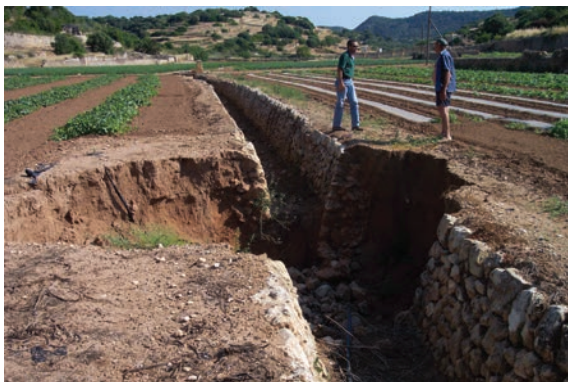
Figura 16: Imatge del col·lapse que va aparèixer al mig del barranc occidental d'Es Migjorn Gran l'any 2005. A la imatge s'observa com el forat va ser reblert pel pagès per pedres provinents d'una paret seca propera, abocant-hi un total de 40 metres lineals de paret.
