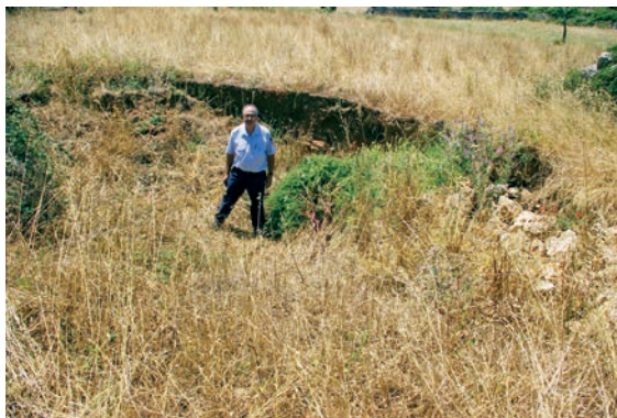
Figure 18: Imatge del col·lapse que va aparèixer l'any 2009 uns 400 metres al nord del col·lapse aparegut l'any 2005. A la imatge s'observa que aquest col·lapse provoca una depressió d'un metre en una àrea de forma circular amb un diàmetre de 5 metres.
