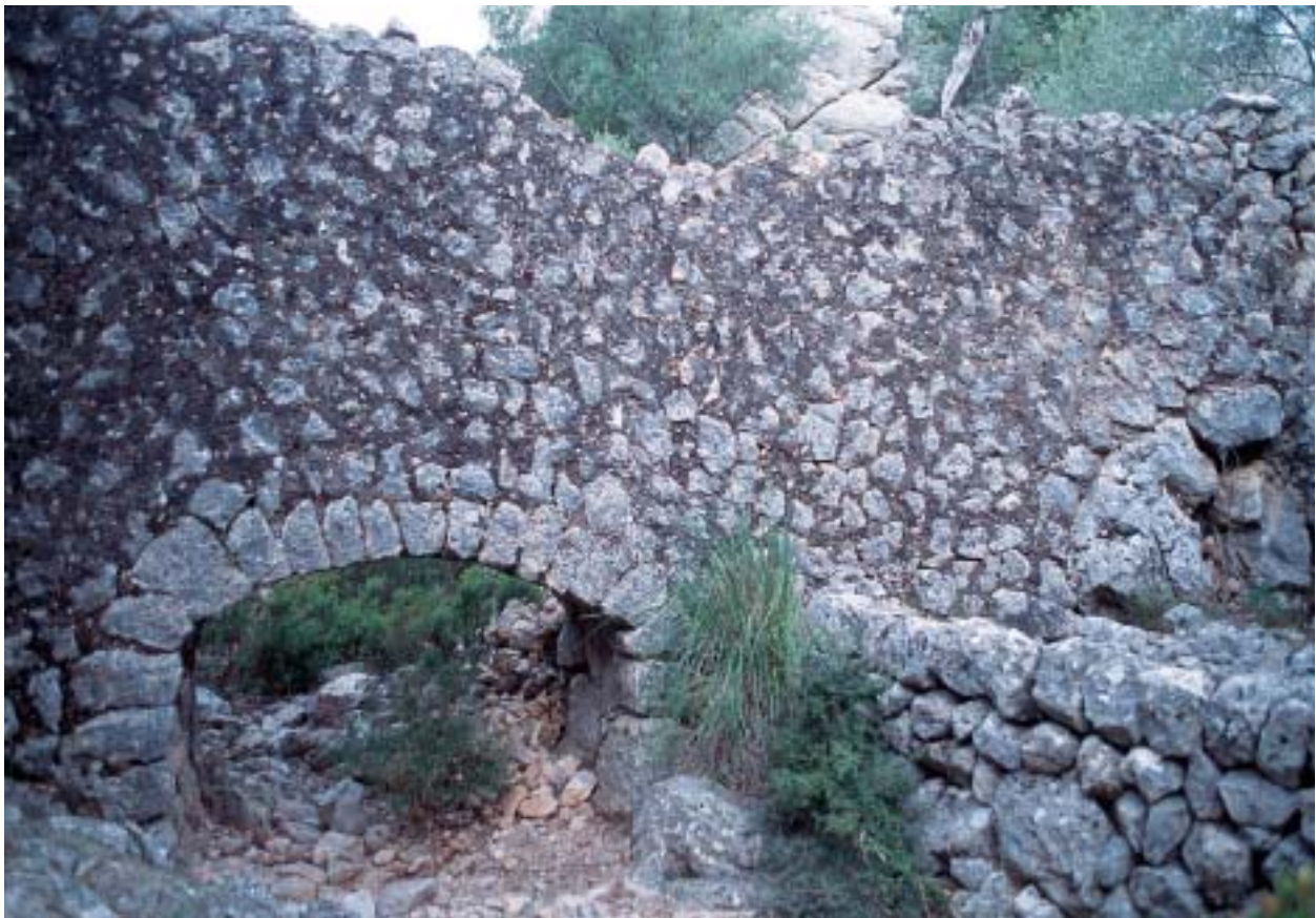
Foto 6: El torrent al seu pas per l'ull del pont que sustenta la canaleta que porta l'aigua de la font Sorda a Son Colomí. Foto: G. Santandreu.
