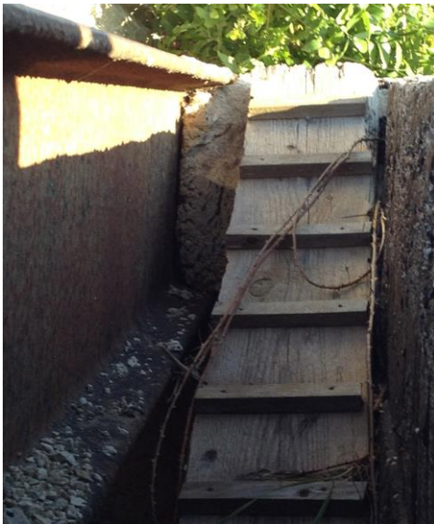
Fig. 6. Rampes situades als passos de bestiar de la carretera del cap de Cavalleria.
