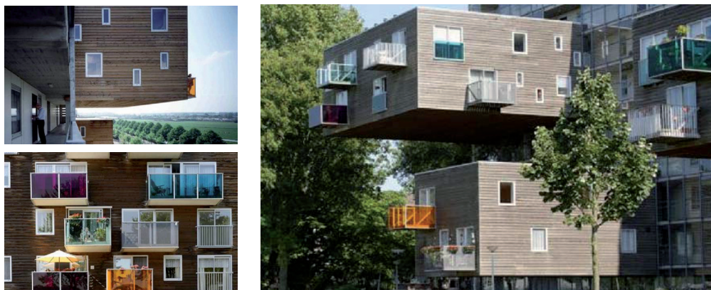
Imatge 9. Edifici per a gent gran WoZoCo, Amsterdam
