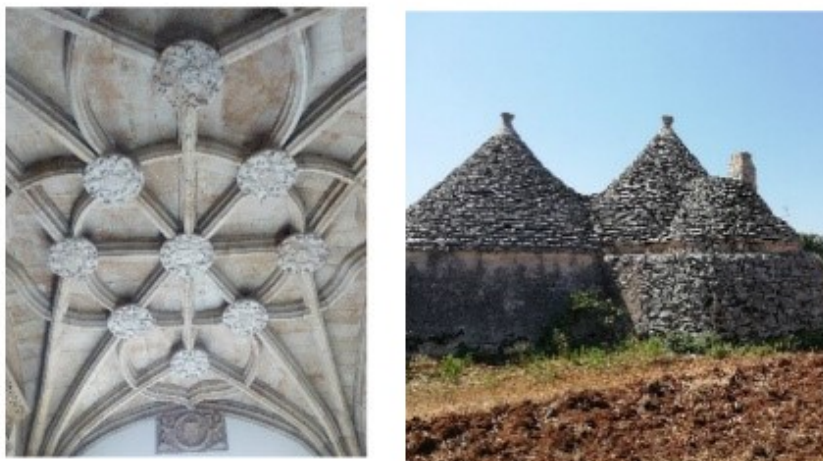
Fig. 1. Calcarenite usata con funzione portante nei trulli in Puglia e come elemento decorativo del soffitto dell'Università di Salamanca
