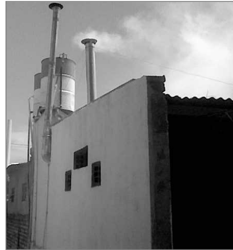
Imagen 26: Ejecución de aberturas para ventilación de los espacios "cocina".
