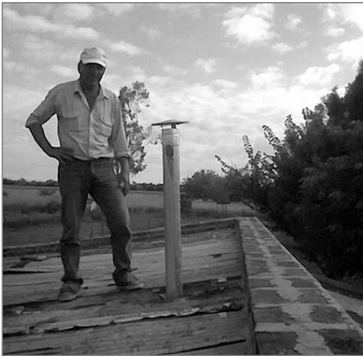
Imagen 25: Ejecución de chimeneas para la evacuación de gases y partículas de sistemas de cocción y horneado existentes.
