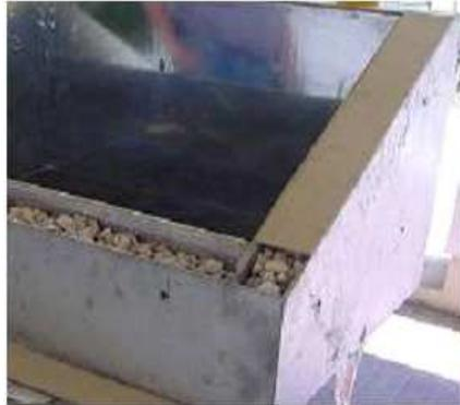
Figura 4: Ejecución de caja interior. Relleno de frente lateral con pomeca puzolánica y colocación de cubiertas captadoras y reflectivas.
