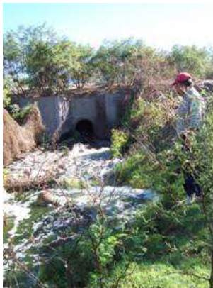
Figura 5. Conducto de descarga del efluente tratado al río Santa Cruz
