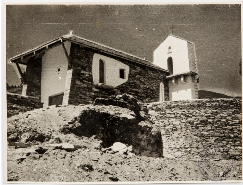
Fig. 5. Chapel for FENOSA in Erberdeiro (Chantada), 1955 Archivo Municipal de A Coruña. Fondo Tenreiro Brochón. Sig. 35 (1)
