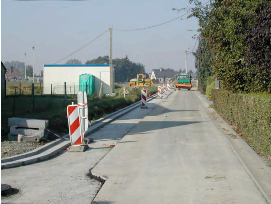
Fig. 2. Sentier Betoïn, Meux.
