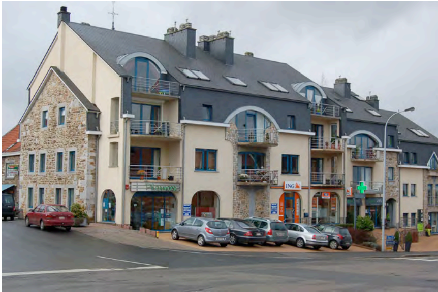
Fig. 2 Jalhay : immeubles d'appartements avec commerces et bureaux au rez-de-chaussée © D. Belayew, 2009.
