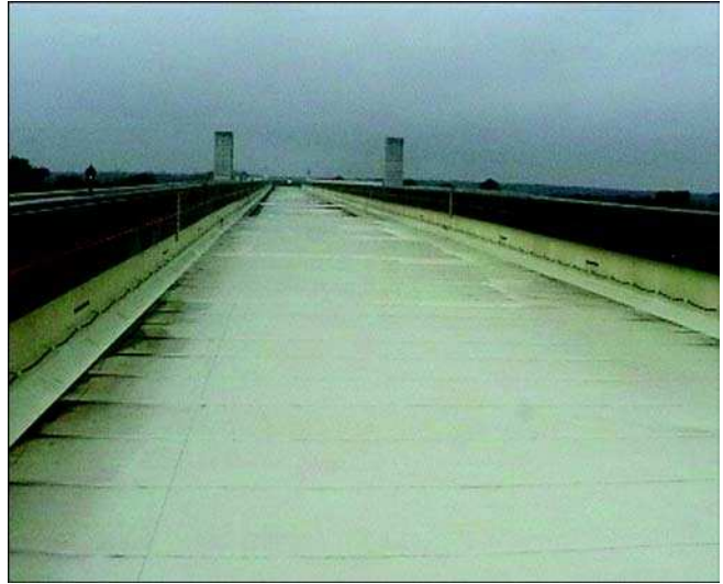
Bild 8.5: 918 m langer, eingelagerter Kanalbrückentrog
