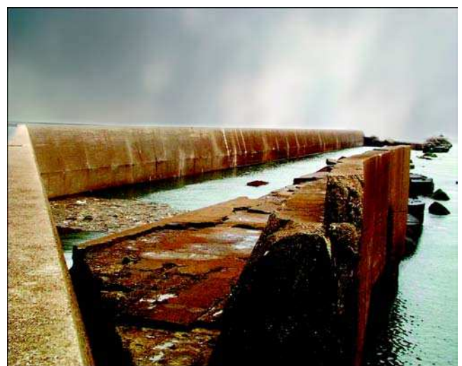
Bild 2.2: Seeseitige Ansicht der Westmole mit vorgelagerter Trümmermole
