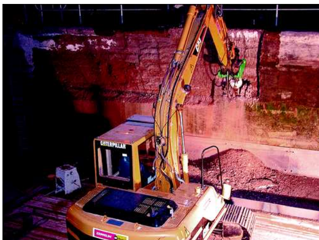
Bild 2.12: Abtrag des Altbetons mittels Fräsen
