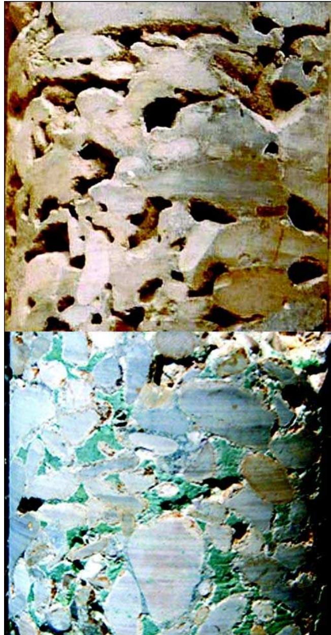
Bild 2.27: Poröser Bohrkern vor der Injektion / Kontrollbohrkern nach der Injektion
