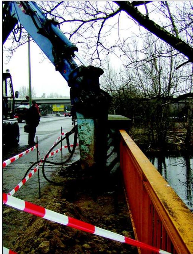
Bild 3.19: Meißelversuch auf der Mörschbrücke
