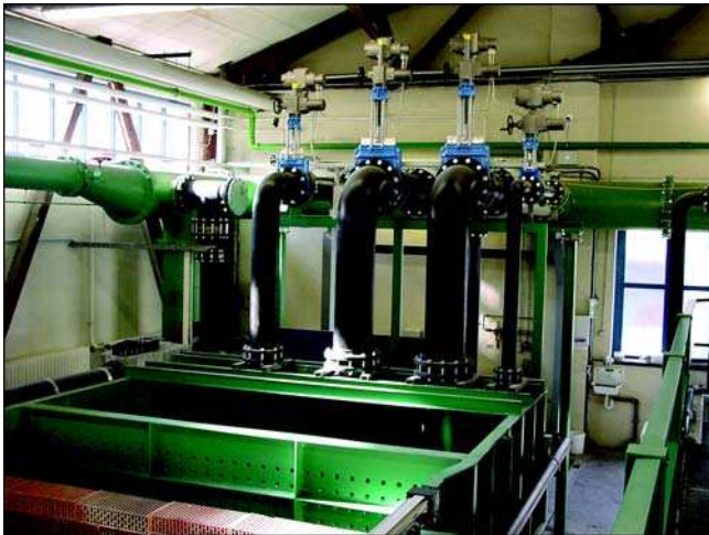
Bild 8.11: Mess- und Stellorgane für den Wasserzufluss
