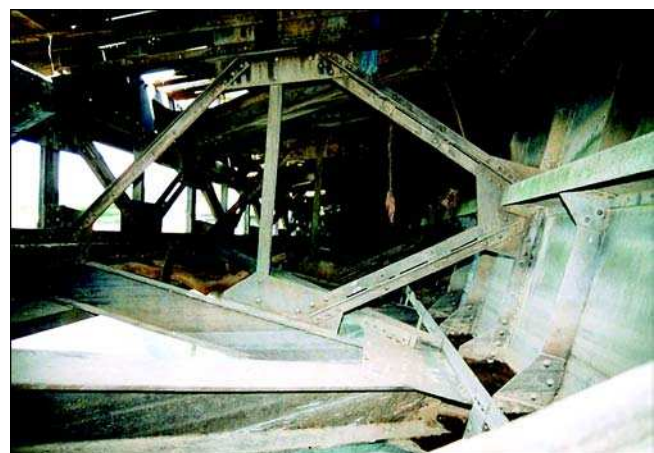
Bild 2.7: Wehr Ladenburg (Unterwasser)
