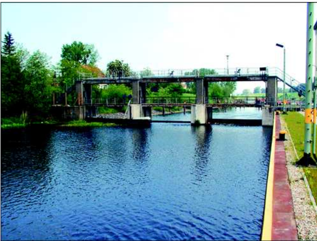
Bild 2.22: Ansicht aus Richtung Oberwasser
