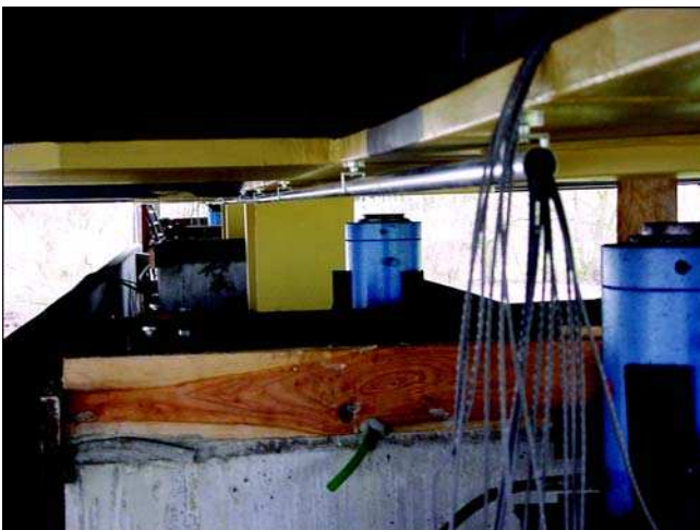
Bild 8.4: Zum Lagereinbau vorbereiteter Auflagerrahmen
