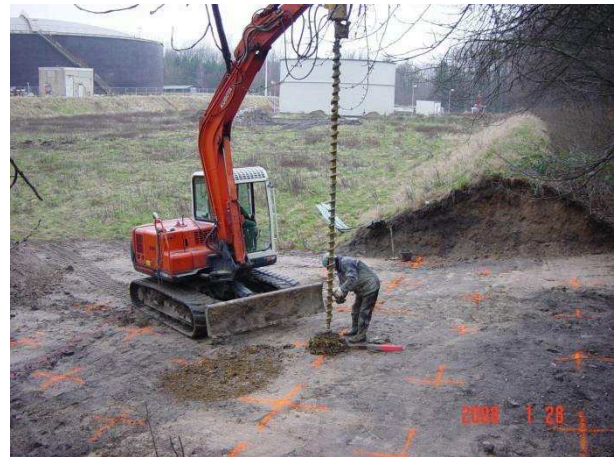
Bild 9: Hohlbohrschnecke im Einsatz mit eingezeichnetem Messraster (rot) Quelle Fa. Schollenberger 2008
