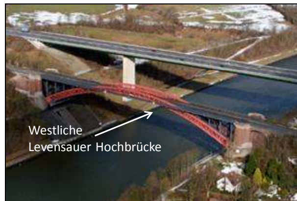
Bild 2: Die Levensauer Hochbrücken am NOK (Foto: www.portalnok.de )
