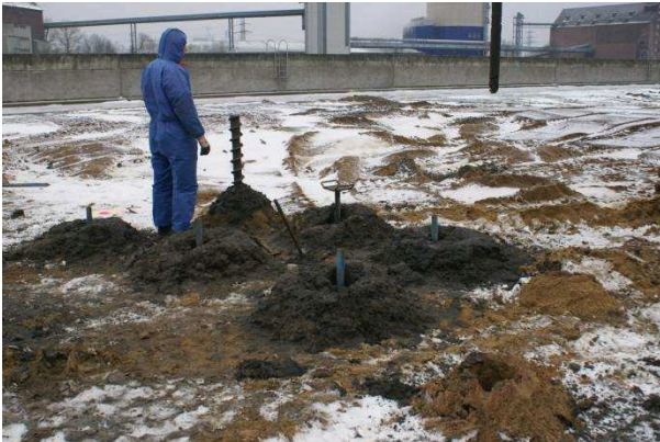
Bild 10: Bohrungen für eine Tiefensondierung Quelle iwB 2011
