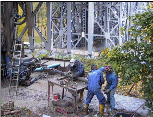
Bild 31: Bearbeitung eines Rammkerns nach der Entnahme
