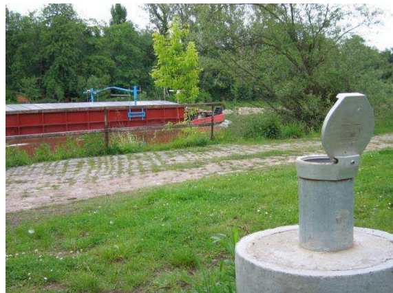
Bild 1: Geöffnete Grundwasser-Messstelle an einer Bundeswasserstraße
