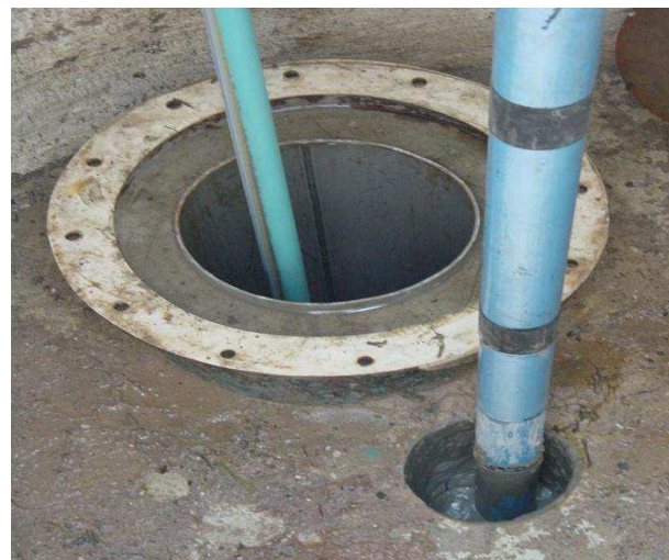
Bild 7: Nachverpressung eines undichten Ringraums in einem Brunnen im Buntsandstein der Nordifel
