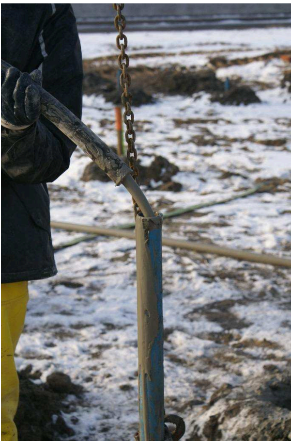
Bild 11: Bohrlochverfüllung mittels Schlauch Quelle iwB 2011
