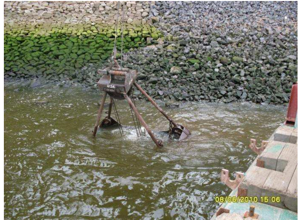
Bild 12: Deckwerksräumung mit Seilgreifer Quelle G.E.O. Monitoring 2010
