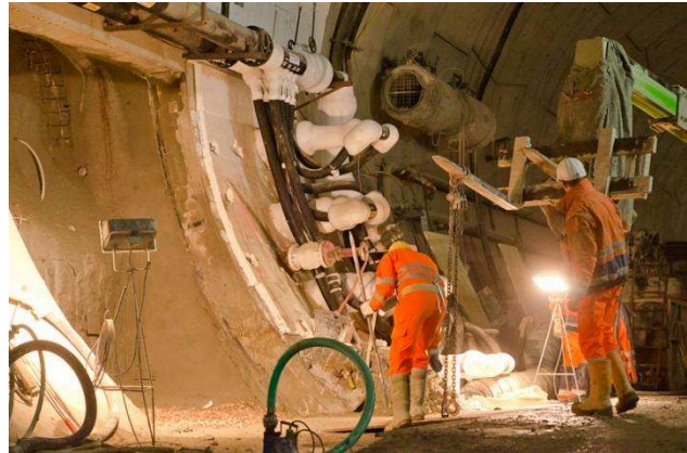
Bild 6: Querschlagsvereisung Finnetunnel; Neubau- strecke Erfurt-Halle/Leipzig
