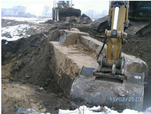
Bild 7: Großflächige Aufgrabungen zur Herstellung eines Sondierhorizontes GPS gesteuert Quelle G.E.O Monitoring 2010
