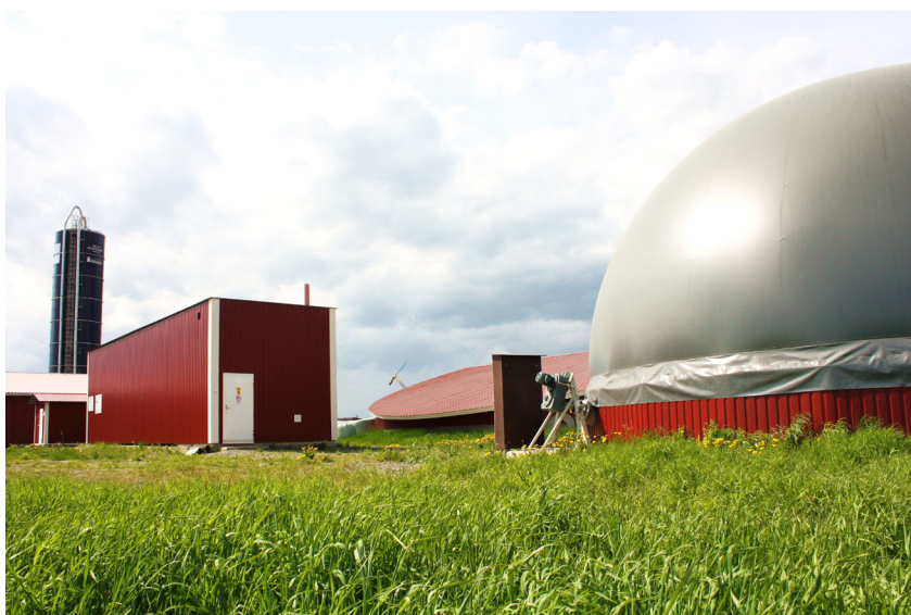
Kuva 7. Yleiskuva Haapajärven ammattiopiston biokaasulaitoksesta. © Steve Malinen
