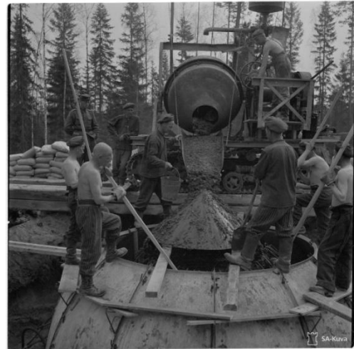
Kuva 3. Pallokorsun valu käynnissä (SA-kuva 2014).
