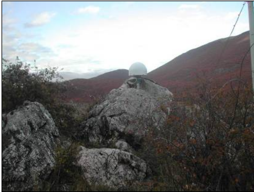
Figura 20. La stazione GPS di Villavallelonga dopo la ristrutturazione. Si nota l'antenna GPS coperta dal Radome.
