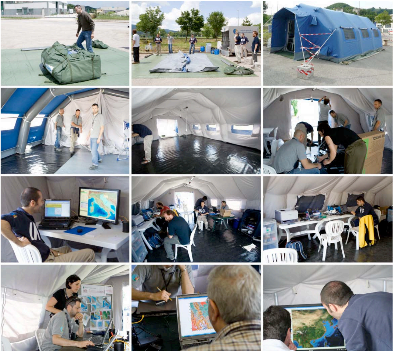
Figura 13. Allestimento del COES: installazione della tenda 6x6m e realizzazione dell'interno e della struttura informatica: terminali, stampanti, rete WiFi e collegamento satellitare.
