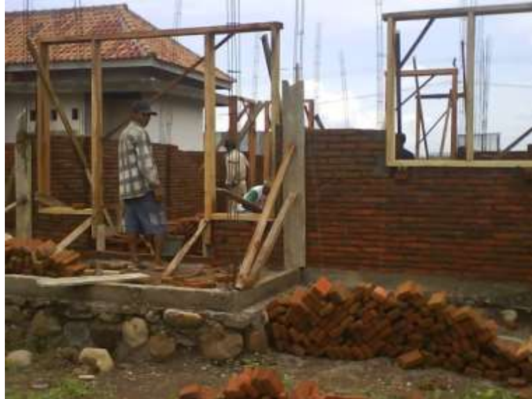
Gambar 9.5. Contoh pemasangan kusen kayu yang dilakukan pada keadaan dinding bata setengah jadi, untuk keperluan pemasangan kupingan kusen dan angkur.
