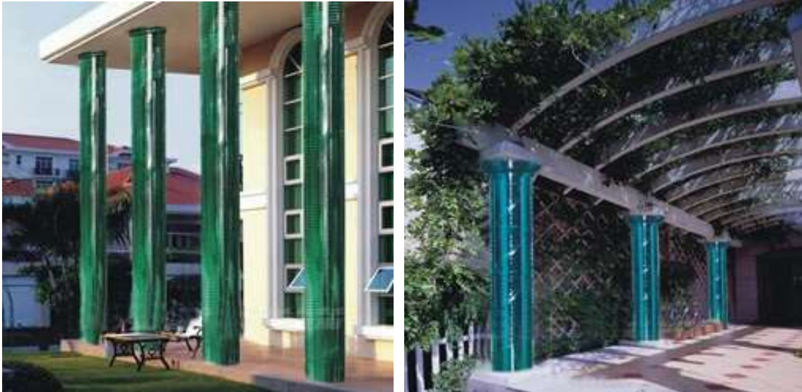
Gambar 8.1. Penggunaan material kaca sebagai kolom untuk menahan/menyalurkan beban yang tidak terlalu besar seperti pada atap teras atau kanopi.
