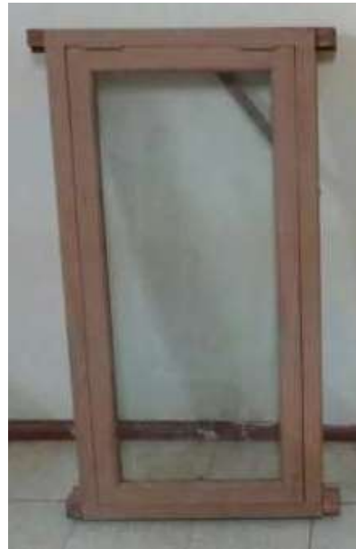
Gambar 9.3. Kusen kayu yang memegang kaca memiliki kupingan dan angkur untuk memperkokoh posisinya setelah dipasang. Hal ini yang membuat kusen kayu tidak memungkinkan pemasangan pada dinding dalam keadaan dinding telah rapi dan jadi.
