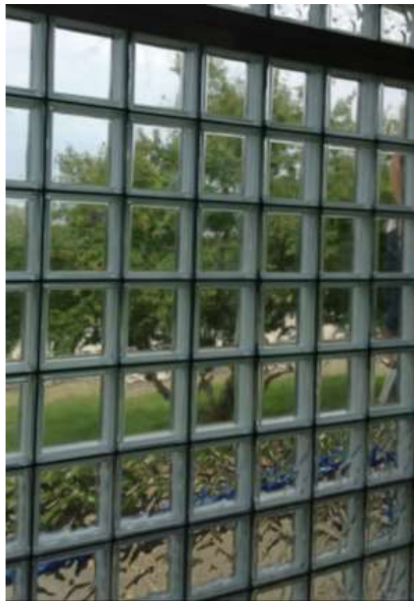
Gambar 2.23. Contoh dua macam blok kaca yang bagian atas halus sehingga cukup tembus pandang, yang bagian bawah bertekstur sehingga kurang tembus pandang. (Sumber http://gratuitxblcodes.com/glass-cubes-for-windows.html )
