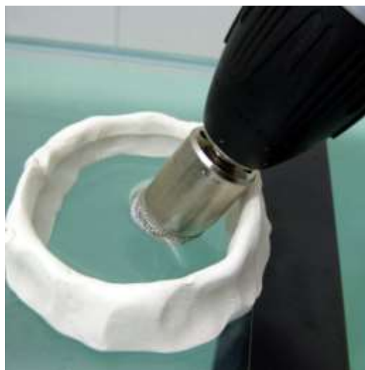
Gambar 9.53. Melubangi kaca dibantu plastisin untuk menampung air. Nampak mata bor diposisikan miring terlebih dahulu untuk mencegah retak atau pecah.
