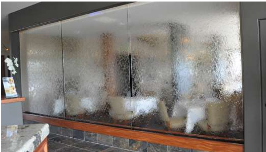
Gambar 9.35. Kaca yang dialiri air untuk memberikan kesan alami dan keindahan. Ketika aliran air berhenti, umumnya kaca berkerak karena kandungan mineral di dalam air. (Sumber http://www.lwaterfalldesign.com/vigiluccis/ )
