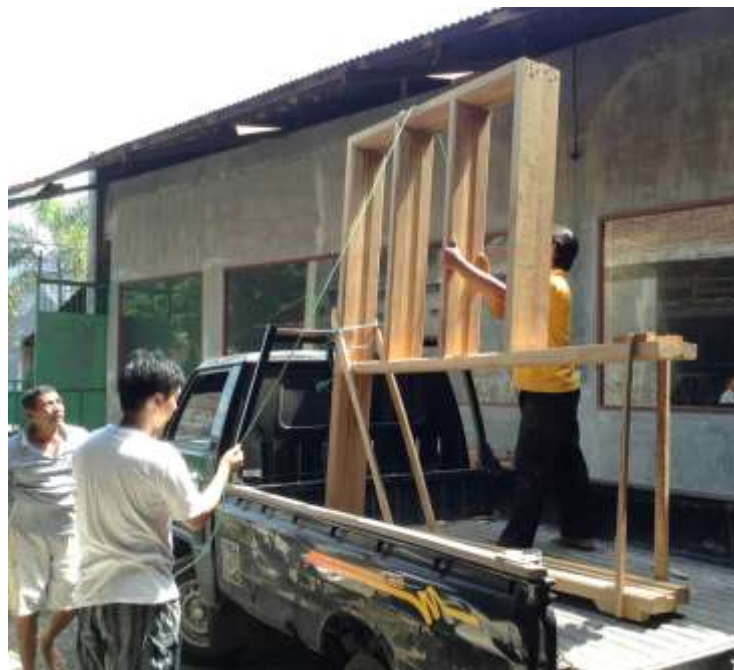
Gambar 9.6. Kusen kayu yang dipesan pada tukang kayu (pembuat kusen) telah siap untuk diangkut ke lokasi konstruksi bangunan.
