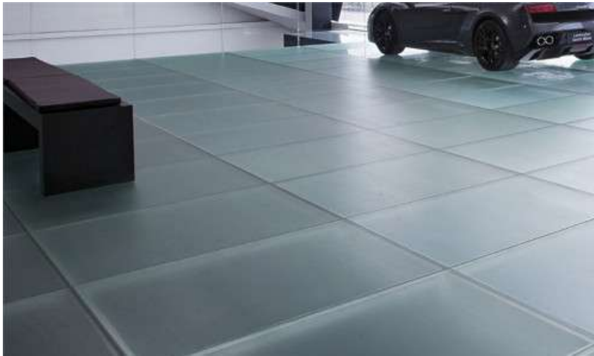
Gambar 8.22. Lantai kaca yang menggunakan sandblasted glass agar tidak licin.
