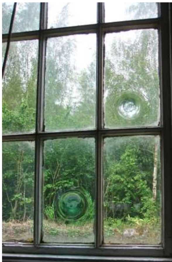
Gambar 4.2. Kaca jendela yang menggunakan bullseye di Gereja St. Michael the Archangel, Sonna, Westmeath. (Sumber https://www.flickr.com/ )
