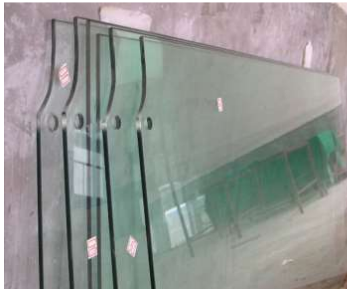
Gambar 9.17. Lubang yang telah disiapkan pada kaca sebelum kaca dipasang dengan sistem tanpa frame .
