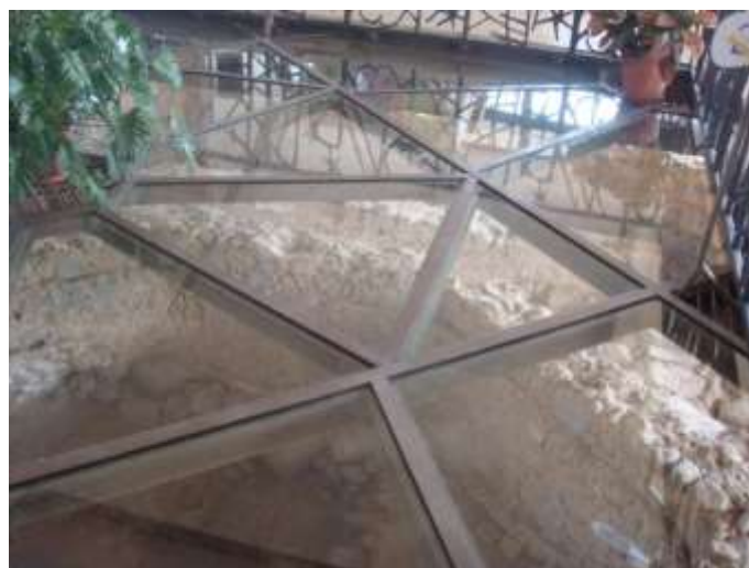
Gambar 8.17. Modul balok penyangga kaca yang kecil-kecil (tidak luas), untuk menjaga keamanan dan kemudahan saat diperlukan penggantian.
