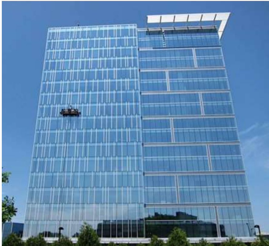
Gambar 9.42. Pekerja pembersih kaca bangunan tinggi menggunakan kereta gantung.
