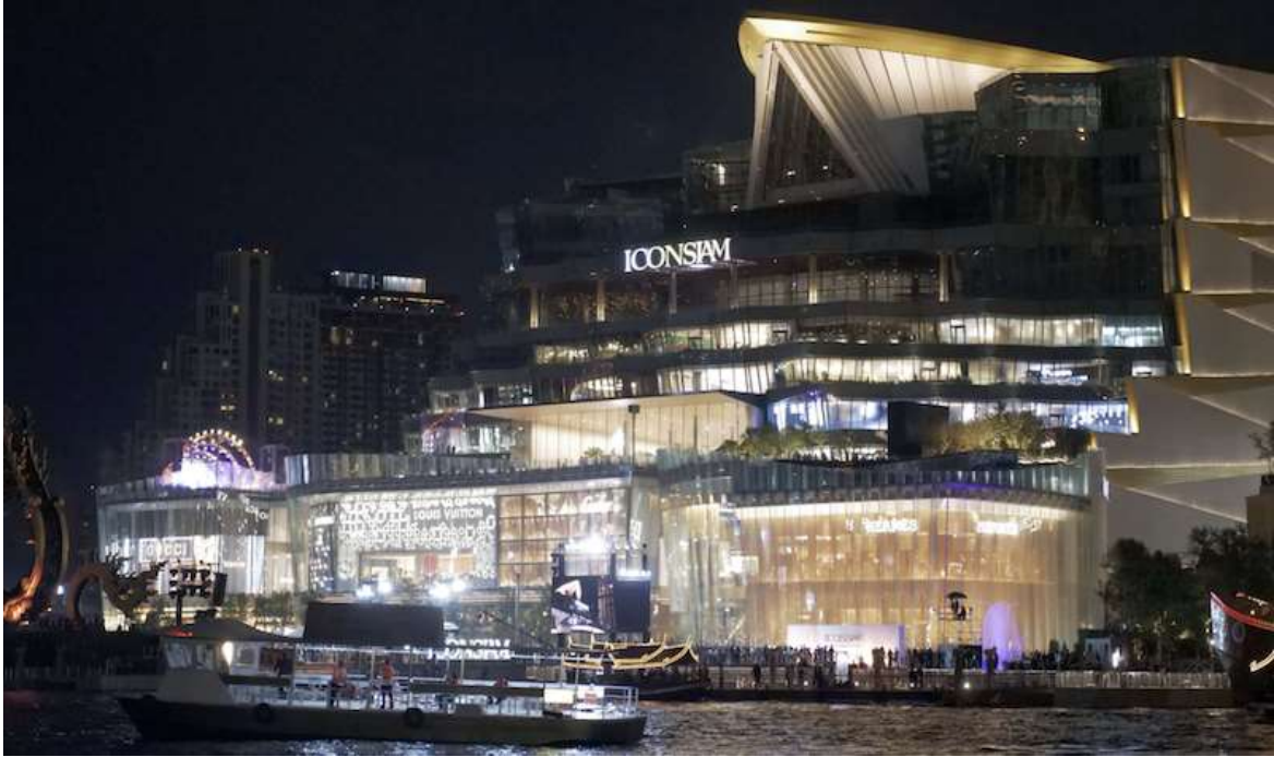
Gambar 8.12. Icon Siam, pusat perbelanjaan baru di Bangkok yang fasad depan bangunannya dipenuhi dinding kaca tersusun dari 333 panel kaca, masing-masing setinggi lebih dari 25 m. (Sumber https://www.bdcnetwork.com/bangkok%E2%80%99s-latest-mega-shopping-mall-features-one-world%E2%80%99s-longest-pillarless-all-glass-facade )
