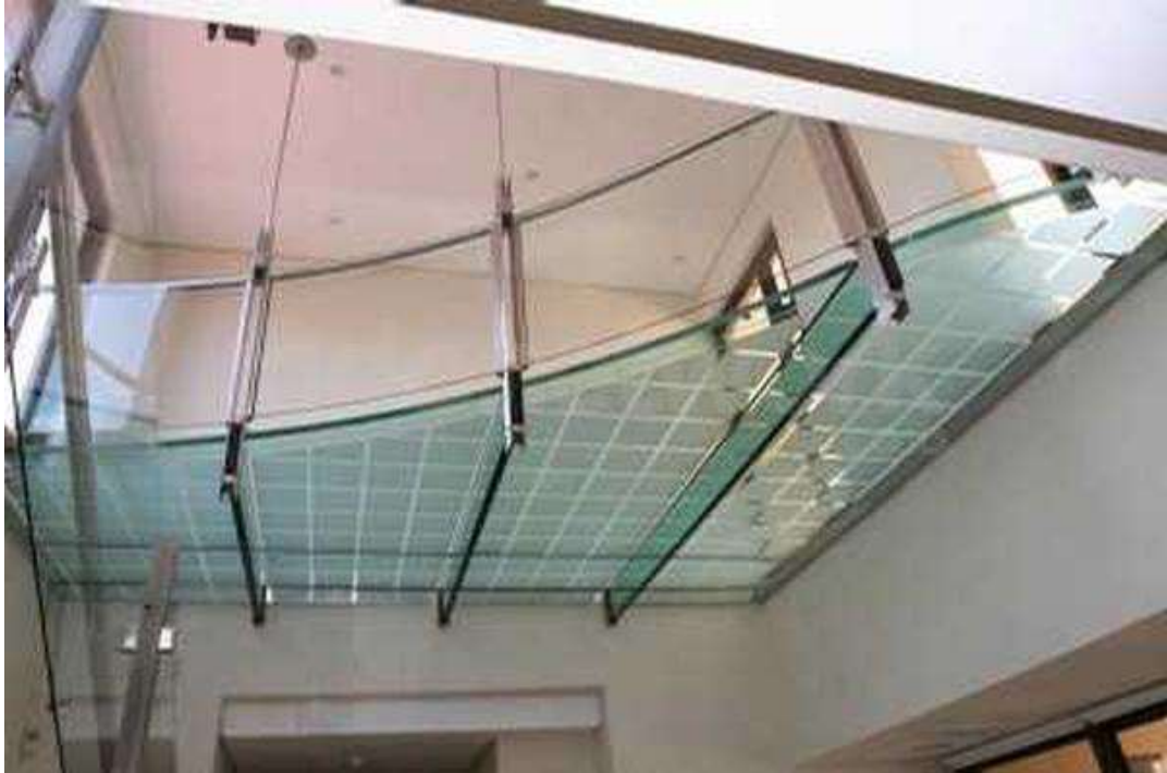
Gambar 8.18. Balok penyalur beban lantai kaca yang juga terbuat dari kaca.
