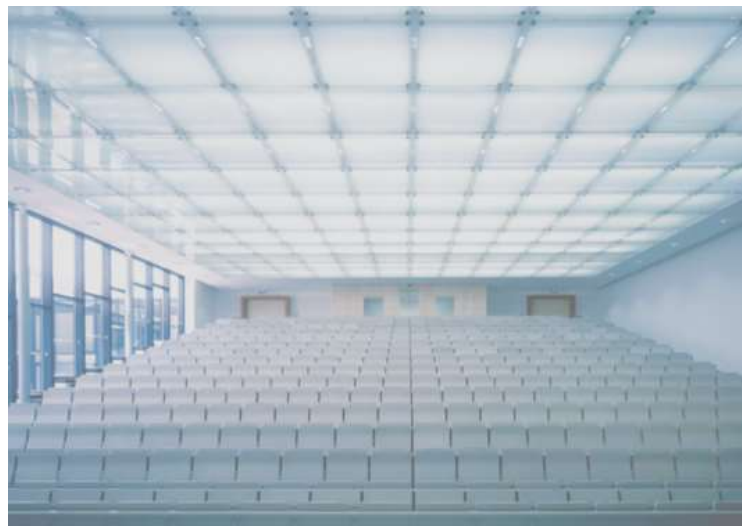
Gambar 8.28. Sebagai rangkaian dari atap kaca yang digunakan untuk meneruskan sinar matahari, maka plafon kaca juga dapat digunakan meneruskan cahaya yang diterima ke dalam ruangan yang dikendaki.
