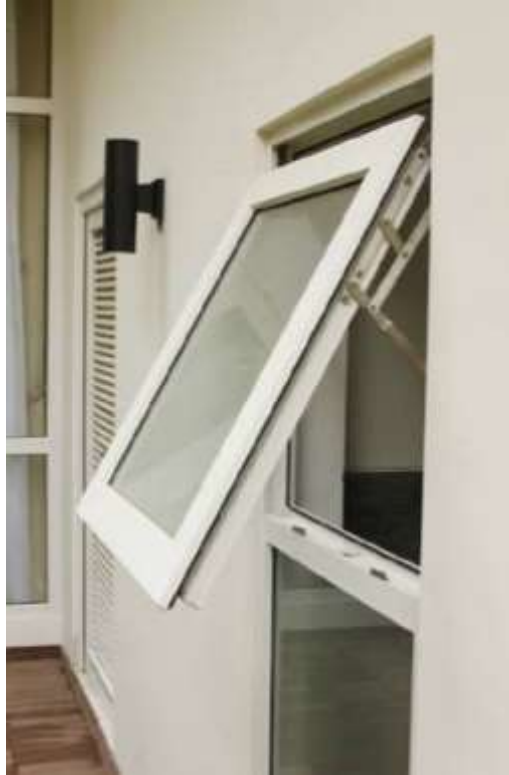
Gambar 9.13. Konstruksi buka tutup pada kusen uPVC yang sedikit rumit namun mencapai kekuatan yang lebih baik dari pada kusen kayu atau aluminium yang umumnya menggunakan sistem engsel sederhana.
