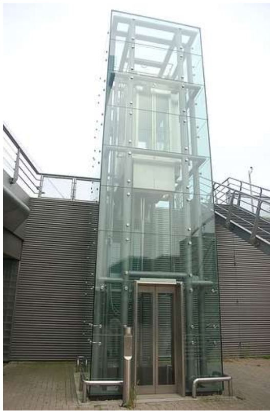
Gambar 8.31. Elevator berdinding kaca yang ditempatkan di luar bangunan, idealnya digunakan kaca khusus bersifat water repellent , agar tidak cepat kotor dan membutuhkan pembersihan terus-menerus.
