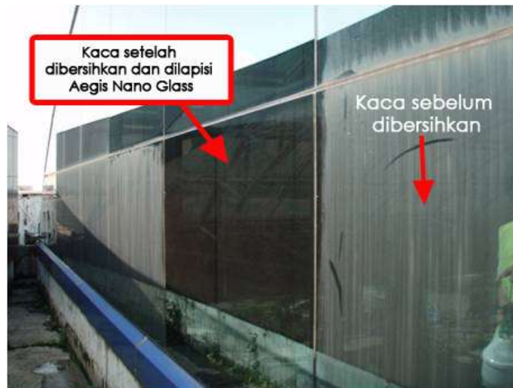
Gambar 9.37. Kerak pada kaca, terlihat kaca yang sudah dibersihkan keraknya dan yang belum. (Sumber http://www.premium-nano-coating.biz/2014/01/kaca-kotor-dimasukkan-dalam-design-awal.html )
