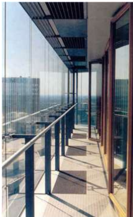
Gambar 8.8. Double-glass-layer pada dinding.
