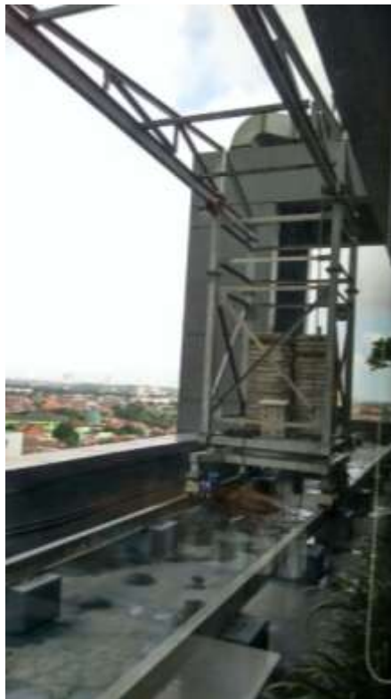
Gambar 9.43. Gondola yang diletakkan pada atap bangunan tinggi untuk berbagai keperluan, salah satunya adalah membersihkan permukaan kaca dinding bangunan tersebut. Gondola bergerak menggunakan rel.
