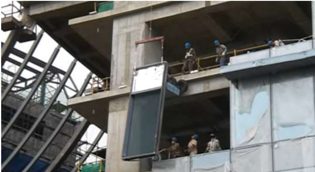
Gambar 9.32. Kaca ber- frame diangkat ke atas menggunakan gondola.
