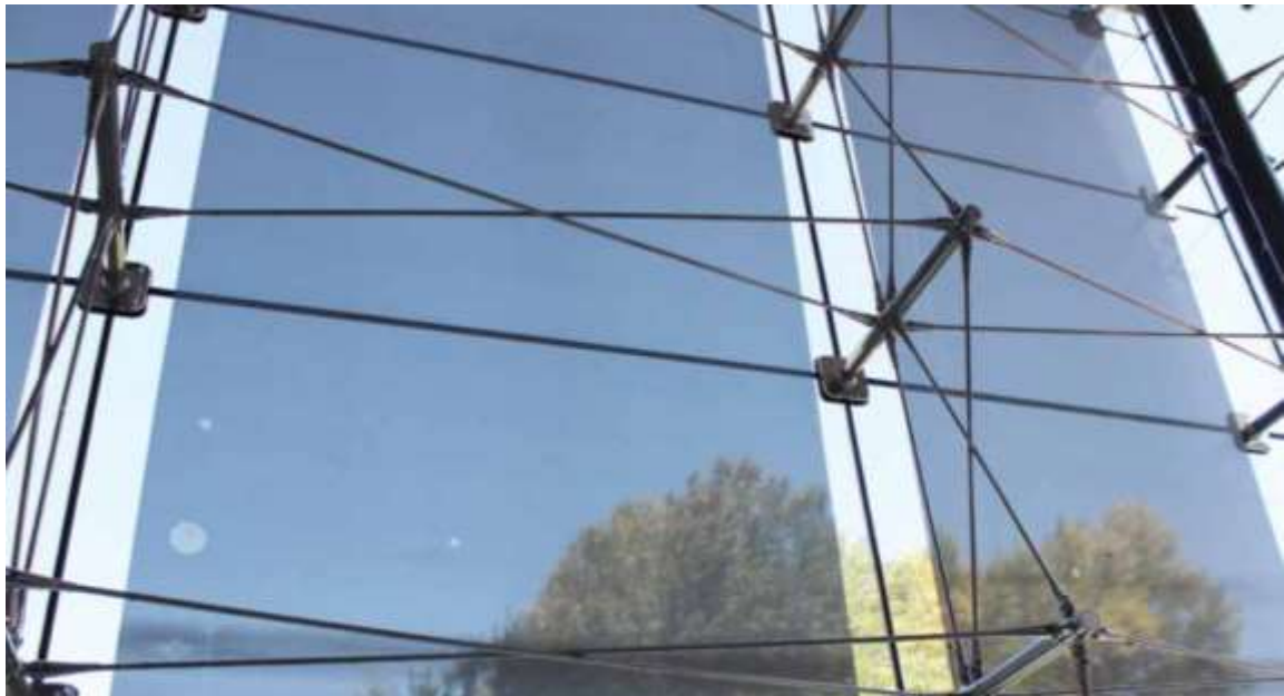
Gambar 9.22. Variasi dari spider fitting (model pemegang tidak seperti kaki laba-laba) dengan penyalur beban kabel.
