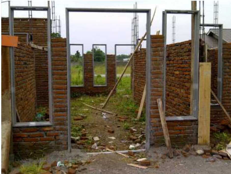
Gambar 9.14. Pemasangan kusen baja ringan pada dinding setengah jadi.
