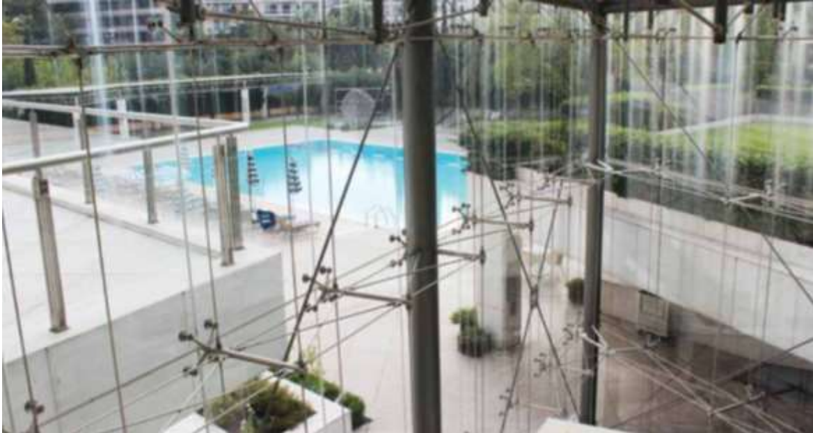
Gambar 9.21. Spider fitting dengan penyalur beban kabel.
