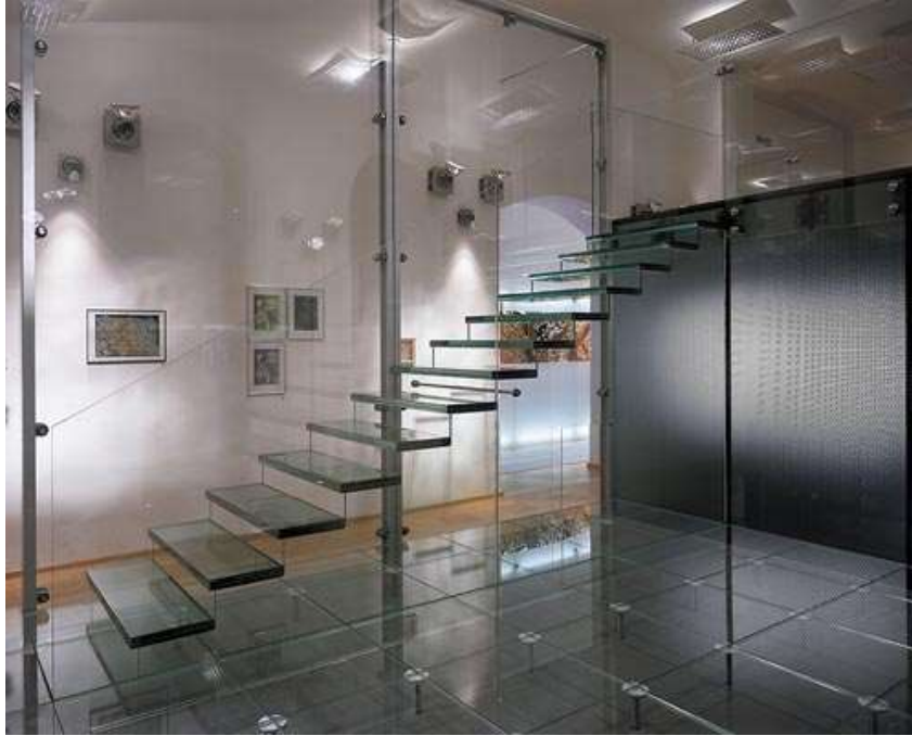
Gambar 8.24. Tangga yang keseluruhan materialnya dari kaca, baik pijakan (anak tangga) dan balustrade (ibu atau pegangan tangga) sehingga memberikan kesan melayang.
