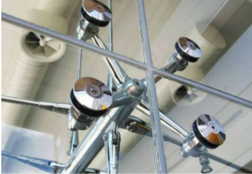
Gambar 9.19. Detil pemasangan spider fittings .
