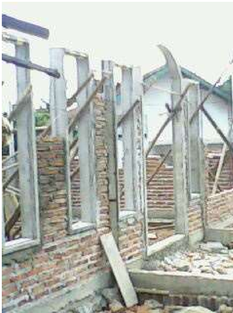
Gambar 9.16. Pemasangan kusen beton pada dinding setengah jadi.
