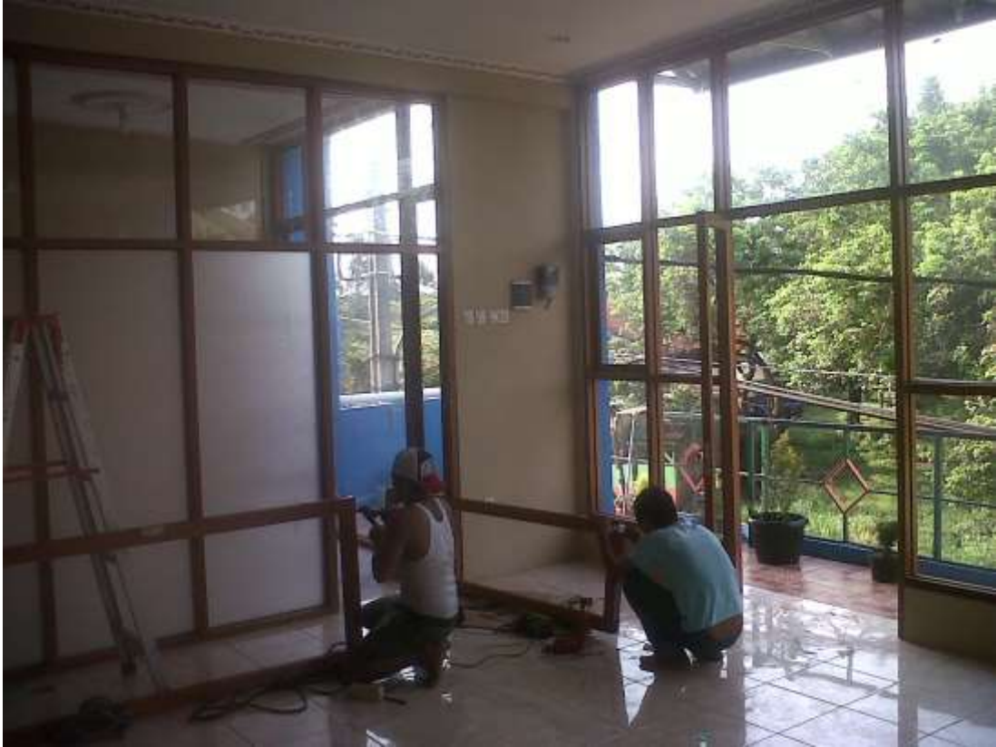
Gambar 9.9. Pemasangan kusen aluminium pada bangunan dilakukan setelah pengerjaan dinding selesai.
