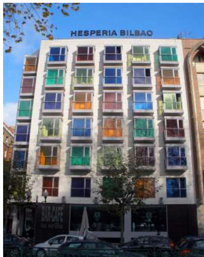
Gambar 2.25. Hotel Hesperia di Bilbao, Spanyol yang menggunakan berbagai warna tinted glass untuk mendapatkan tampilan yang menarik. (Sumber https://id.pinterest.com/pin/174584923027826685/ )
