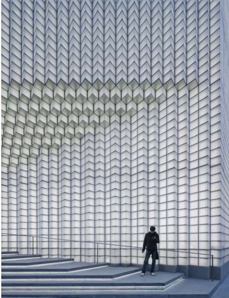
Gambar 2.40. Detil penggunaan blok kaca secara masif pada area masuk toko pakaian di Shanghai. (Sumber https://archpaper.com/2015/09/uufie-transforms-flagship-store-with-icy-cool-glass-block/ )
