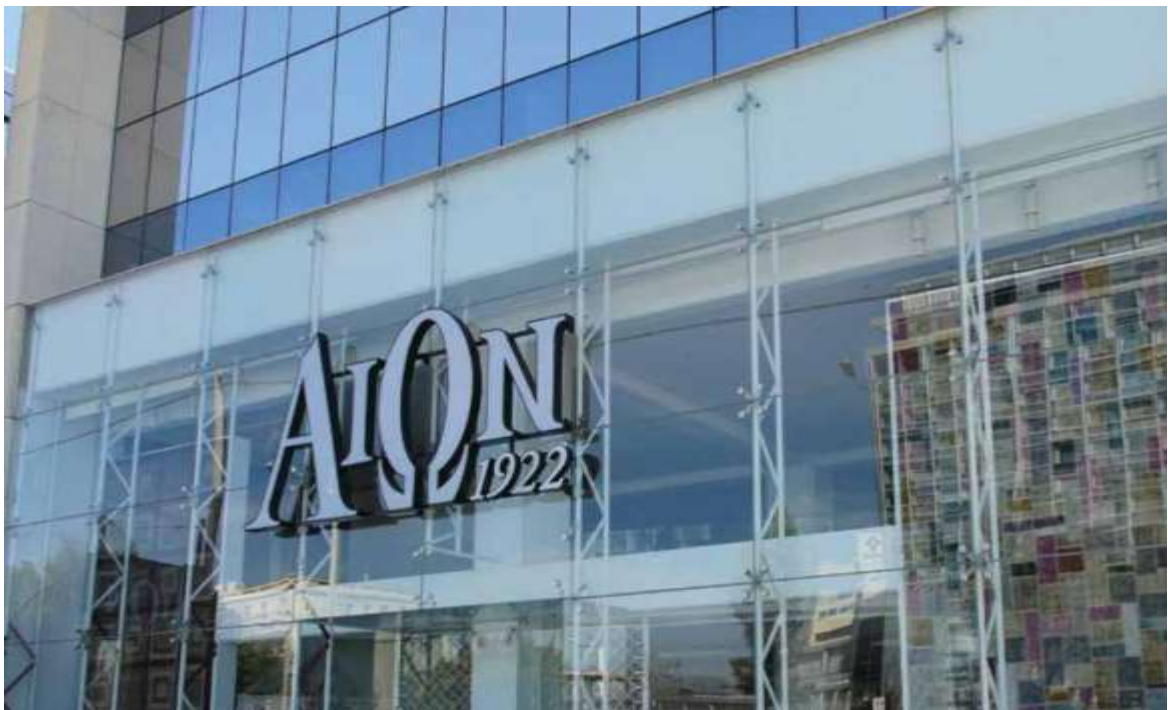
Gambar 9.20. Spider fitting dengan penyalur beban truss .
