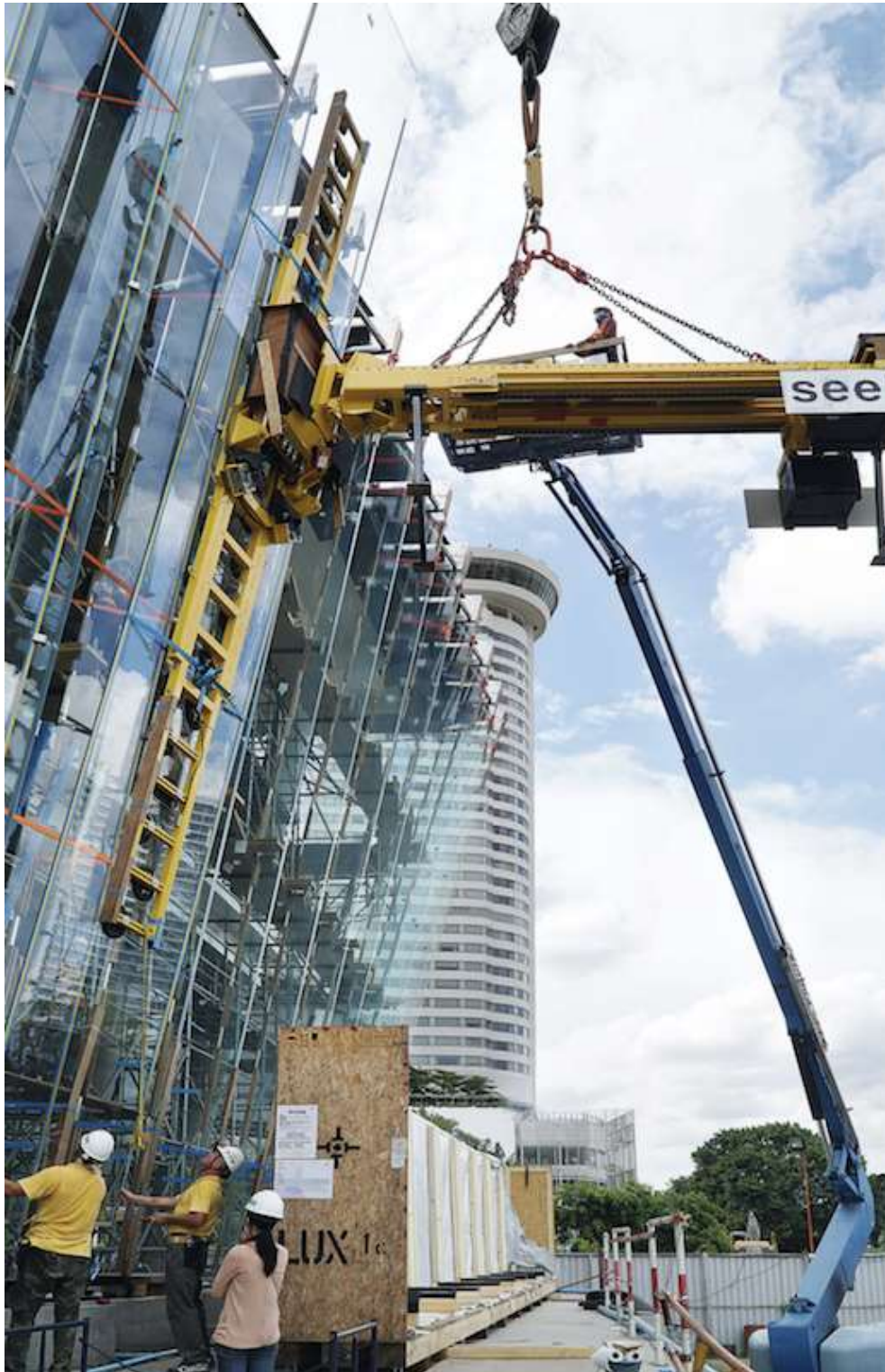
Gambar 9.25. Proses pemasangan kaca di Icon Siam Bangkok, dengan panel kaca masing-masing seberat 3,5 ton dan tinggi mencapai 25,6 m. Panel disangga oleh sistem glass fins , dipasang menggunakan 2 vakum khusus dengan bandul, agar dapat memasang kaca pada sudut kemiringan berbeda-beda. (Sumber https://www.bcnetwork.com/bangkok%E2%80%99s-latest-mega-shopping-mall-features-one-world%E2%80%99s-longest-pillarless-all-glass-facade )
