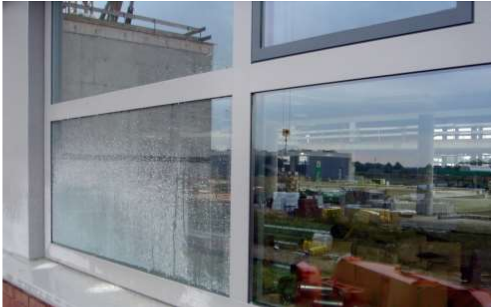
Gambar 2.59. Kaca yang mengalami pelapisan nanoscopic (kanan) dan tidak (kiri). (Sumber https://thomann-hanry.co.uk/metal-cleaning/glass-restoration/ )
