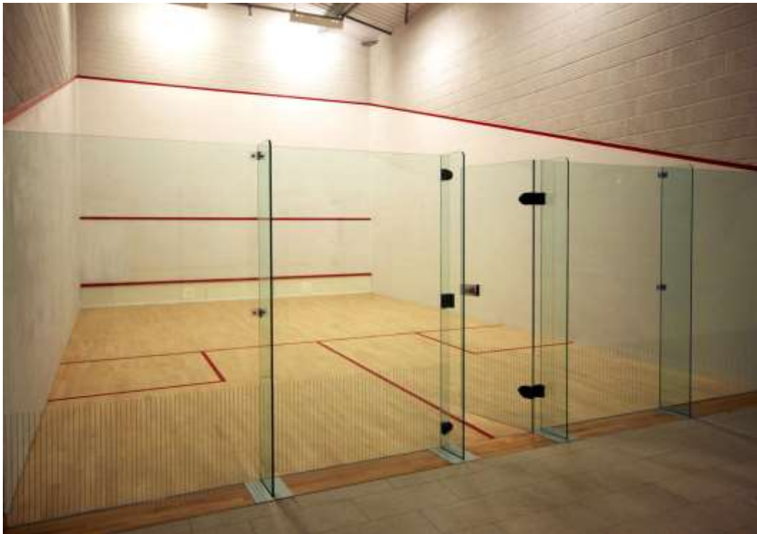
Gambar 9.29. Dinding kaca yang dipasang dengan sistem sirip kaca, namun tanpa pemegang model spider , hubungan antar kaca diperkuat dengan klem yang tetap melubangi kaca. Di sini digunakan kaca temperasi-laminasi, karena sebagai pembatas ruang olahraga squash.
