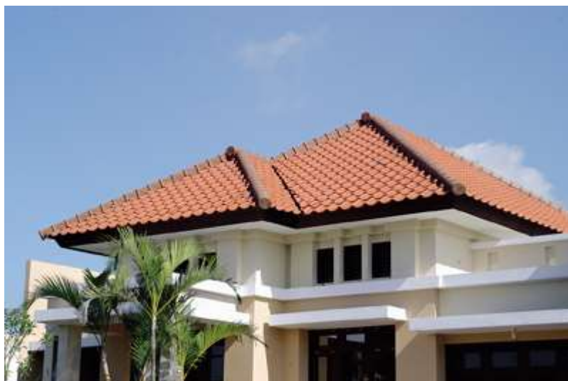
Gambar 8.6. Bagian atap yang menjorok melebihi dinding adalah teritis yang akan melindungi kaca dari paparan sinar matahari langsung. Teritis dapat berupa perpanjangan atap, maupun dibuat tambahan pada posisi lebih ke bawah, untuk melindungi jendela kaca, seperti pada gambar ini, ada dua macam teritis: langsung dan tambahan.
