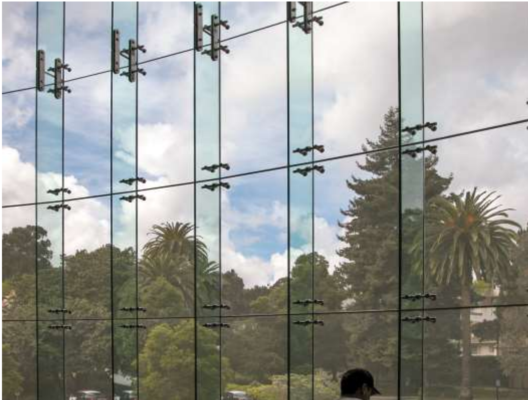
Gambar 9.23. Variasi spider fitting dengan penyalur beban sirip kaca ( glass fins ).
