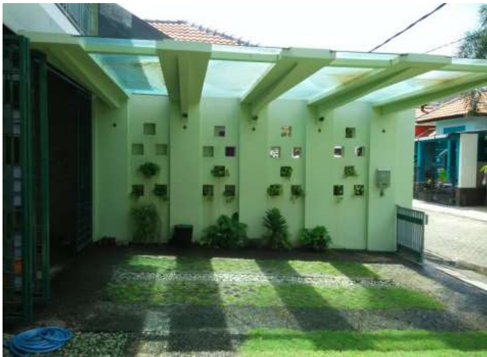
Gambar 9.58. Kaca film warna hijau yang dilapiskan pada kanopi kaca agar sesuai warna dinding.
