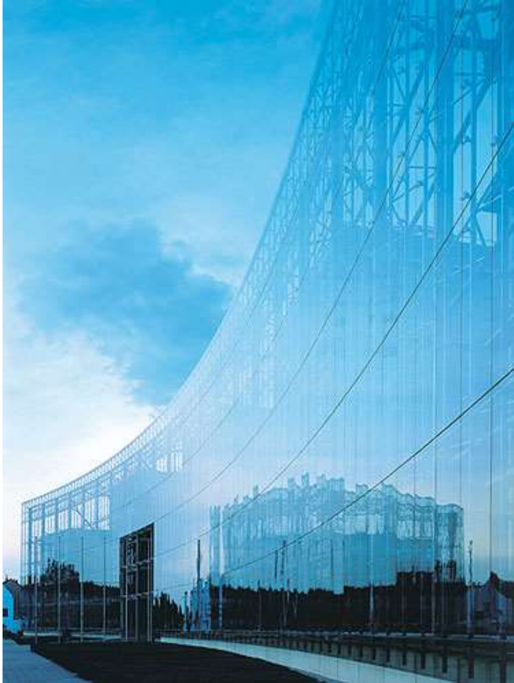
Gambar 8.13. Dinding kaca penuh sebagai sound barrier di Cologne, Germany.
