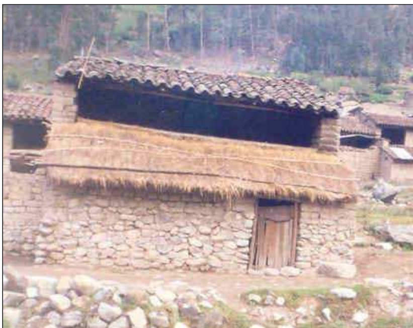
Fig. 35. Vista de una vivienda en la parte marginal de la ciudad de Marca con techo de “ichu” Stipa ichu (R. & P.) Kunth.
