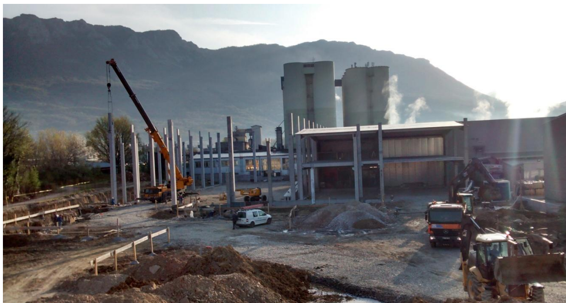
Slika 12: Postavitev stebrov (Starc, 2015)
