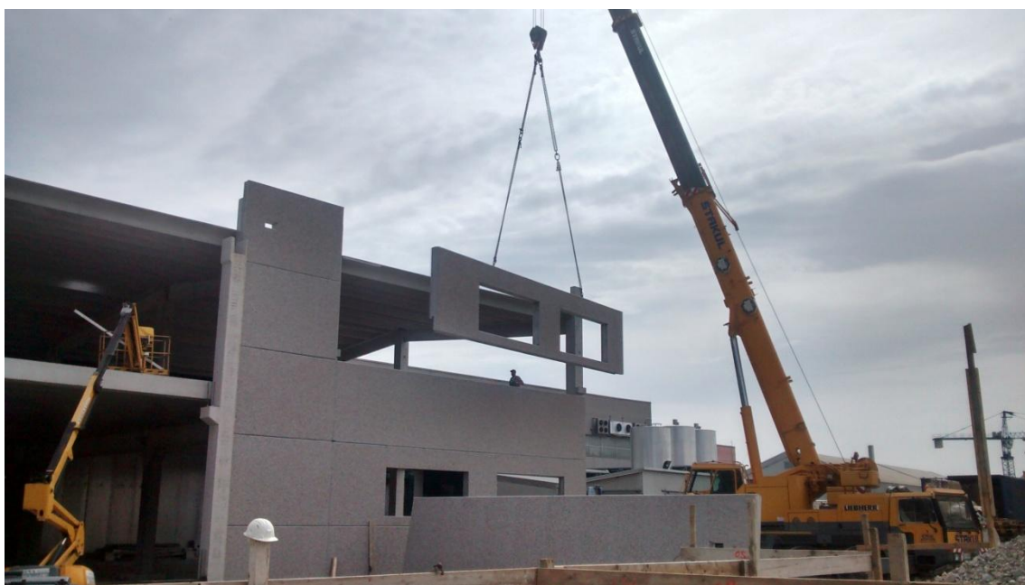
Slika 14: Postavitve montažne stene (Starc, 2015)
