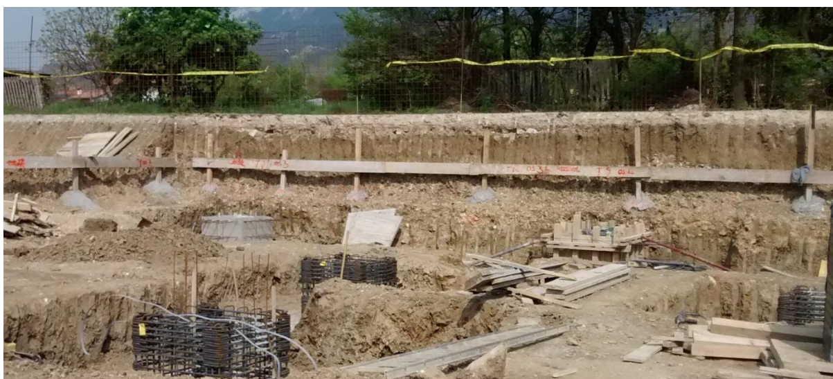
Slika 9: Prikaz gradbenih profilov in označitev osi (Starc, 2015)
