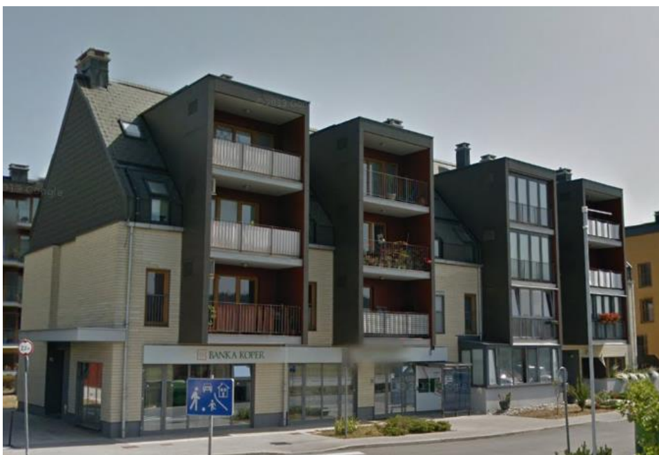
Slika 3: Sončni log 1, 1a. Pogled s ceste na J stran objekta
