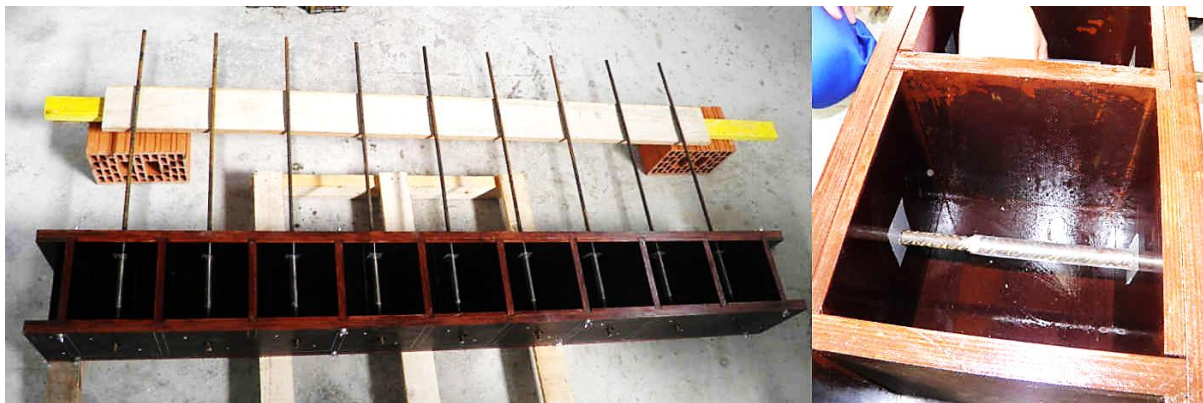
Slika 10: Levo pripravljen kalup, desno položaj plastične cevke na armaturi
