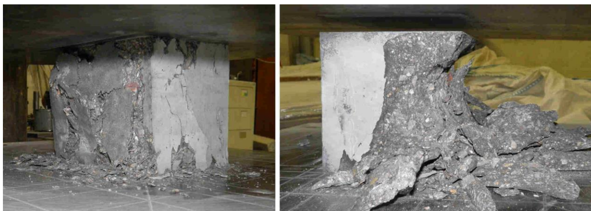
Slika 12: Na levi: porušitev vlaknastega betona; na desni: porušitev betona visoke trdnosti
