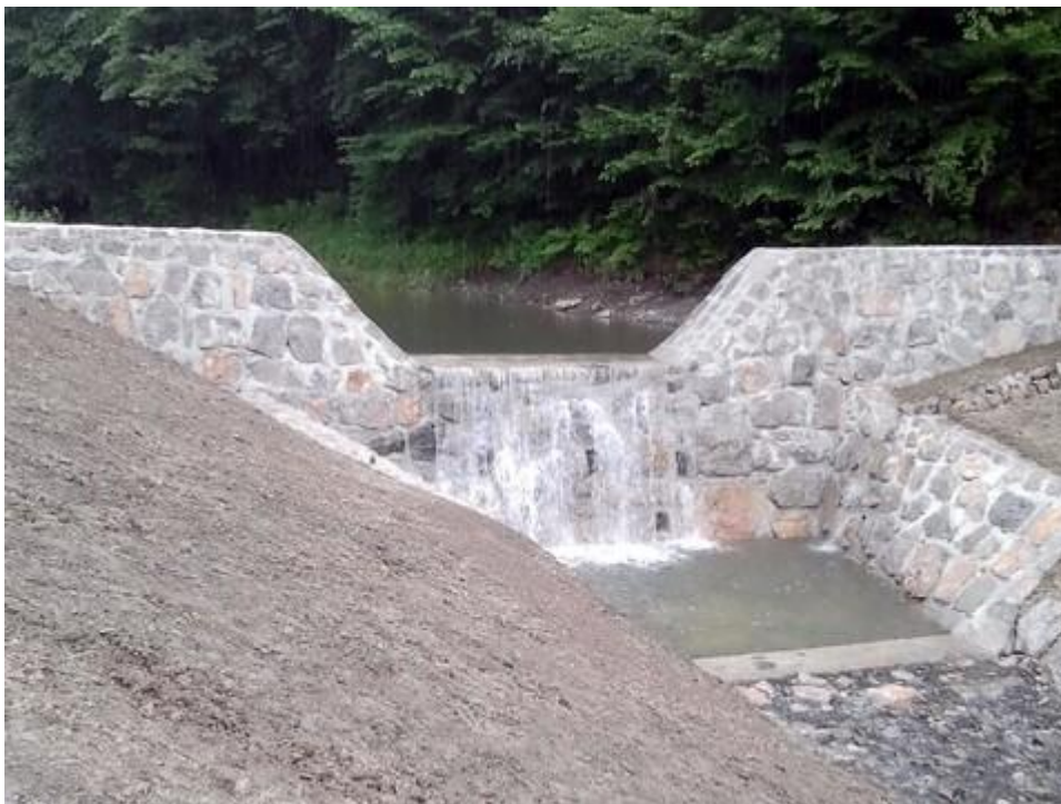
Slika 9: Hudourniška pregrada na Prosci nad Dolenjo vasjo (Hidrotehnik, 2013)
