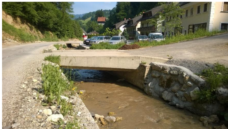
Slika 14: Številne premostitve potoka Hotoveljščica (avtor, terenski ogled 1.6.2015)
