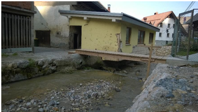
Slika 13: Nedovoljena gradnja objektov preko struge (avtor, terenski ogled 1.6.2015)
