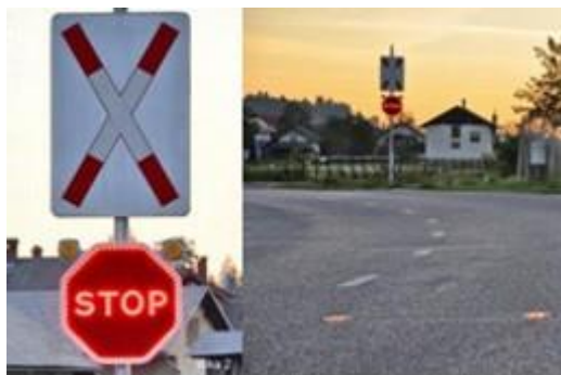
Slika 20: Stanje po dodatnem zavarovanju pasivnega nivojskega prehoda [49]
