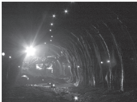
Slika 3: Pogled iz raziskovalnega rova s stojišča instrumenta proti čelu predora. Jasno so vidne svetleče detaljne točke na posameznem profilu (ena na stropu, ena na tleh in dve v boku). V ozadju potekajo dela na čelu predora.
