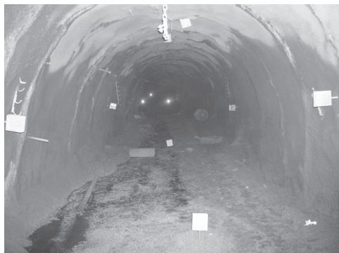
Slika 5: Pogled s čela predora v raziskovalni rov. V ospredju so vidne detaljne točke z zaščitami, v ozadju pa tri svetleče dane točke, na katere se izvaja navezava.
