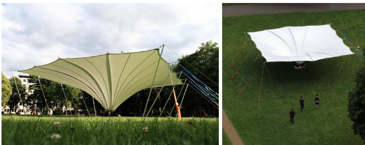
Slika 4-9: Konusna konstrukcija za Marakeško šolo razstavljena v parku [5]
