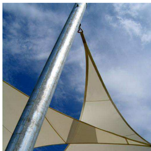
Slika 4-20: Nadstrešek terase padalske družbe (levo zgoraj), detajl križanja koncev dveh jader (desno zgoraj), detajl obhoda enega jadra okoli drugega (levo spodaj) ter steber z vpetim jadrom (desno spodaj) [23]
