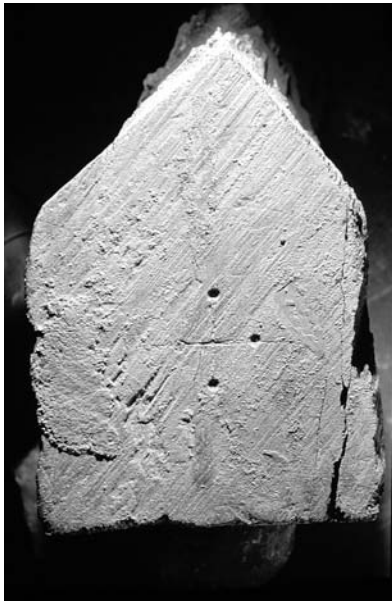
Fig. 25. Konsollen har et steinhuggermerke på oversiden. Se kap. 1.9.
