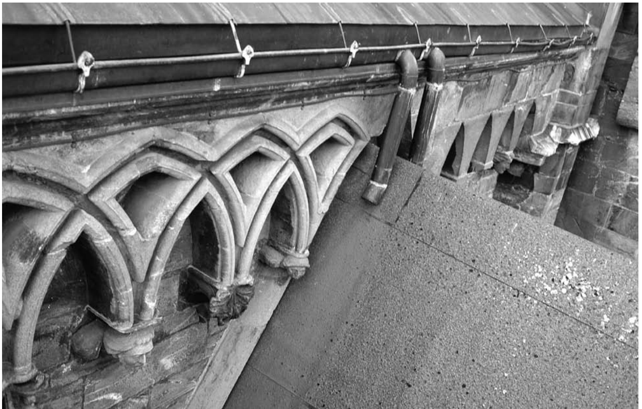
Fig. 17. Nordveggenes gesims fotografert fra lift. Vestsiden av gavlen mangler profiler i buene, men dimensjonene er identiske på begge sider av gavlen. Foto: Kjartan P. Hauglid, 1997
