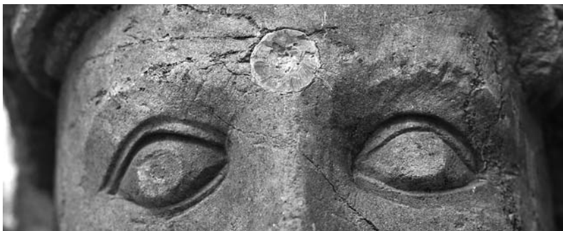
Fig. 33. Gesimshode innmurt på sørsiden av koret, med bolt i pannen.
