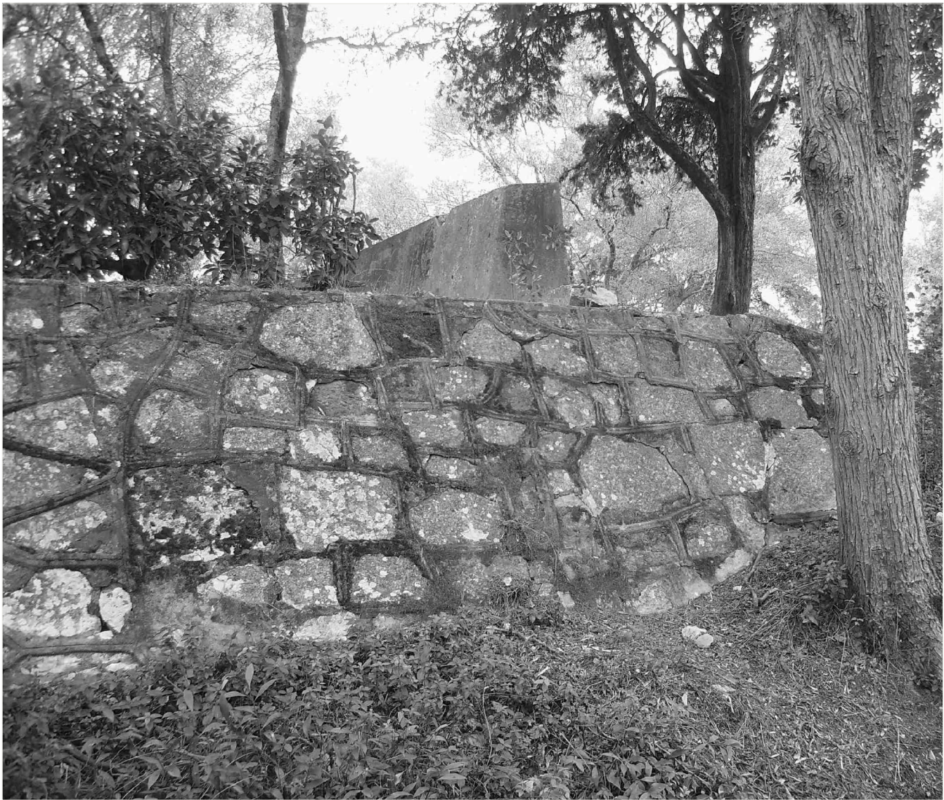
FIG. 44 Fotografia da Muralha da Luneta dos Quartéis
