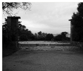
Fig. 18 Miradouros no Parque Florestal de Monsanto - Miradouro Luneta dos Quartéis.
