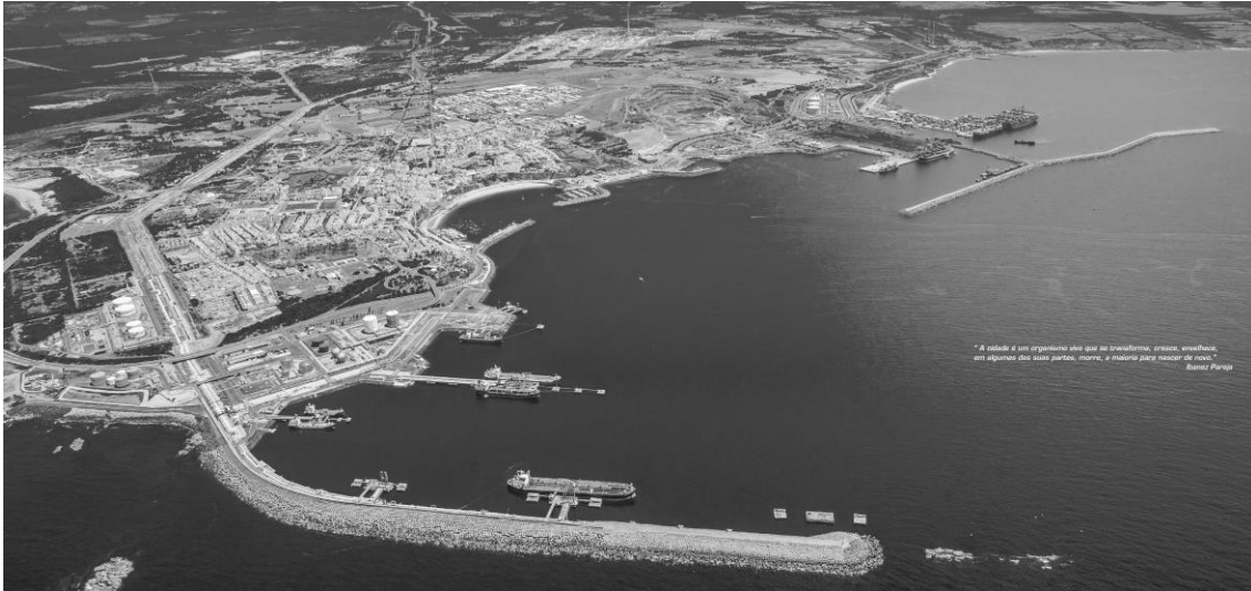
Figura 1 - Vista Aérea Sines
