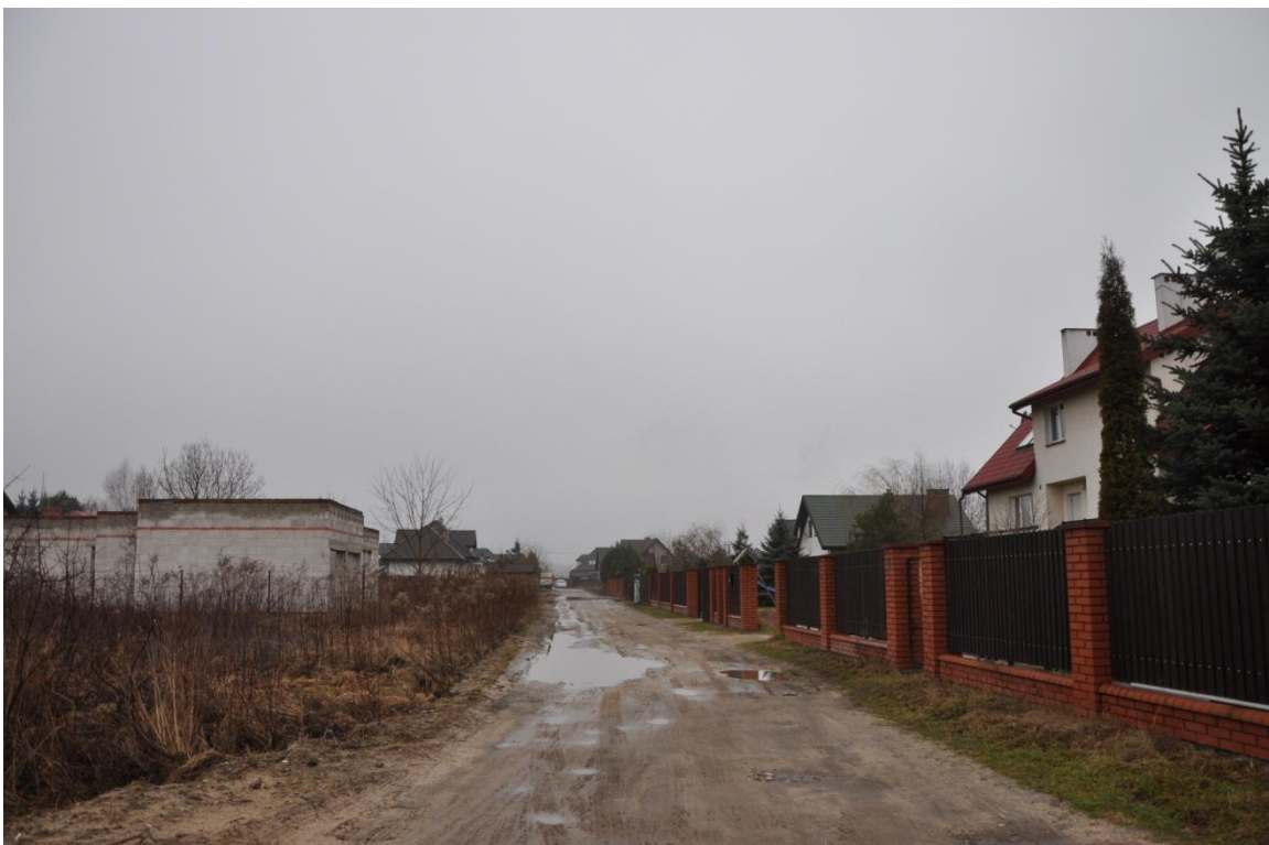
Powstająca zabudowa jednorodzinna w Ustanowie. Fot. M. Woźniak
