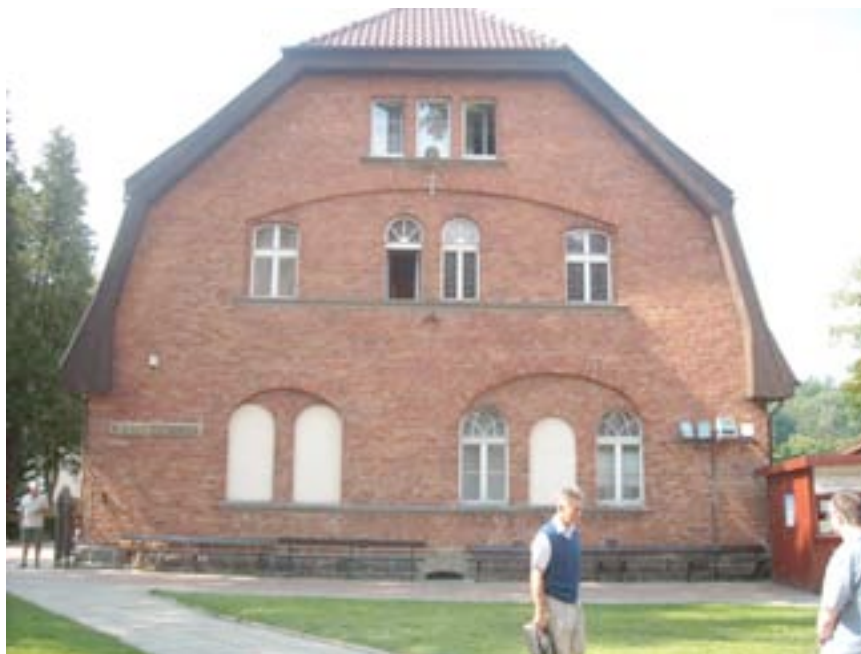
Fot. 4 Boczna elewacja domu parafialnego w stylu warmińskim.
