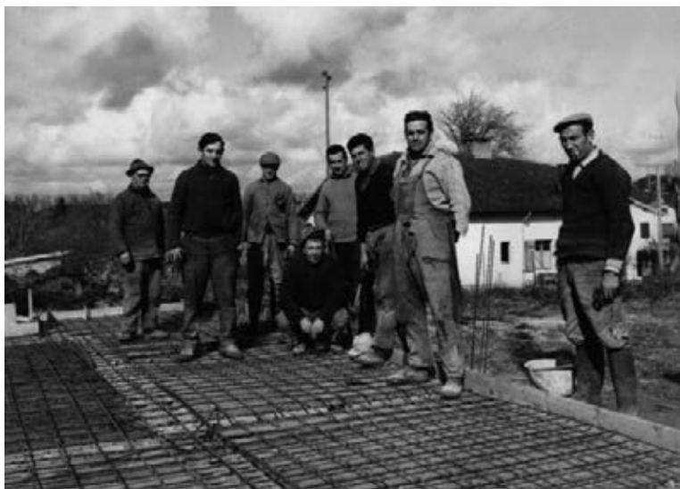
Trabajadores emigrantes españoles y franceses en obras de la construcción en las cercanías del municipio de Castel (Departamento de Landes-Región de Aquitania), ca. 1967-1968. (Fotografía cedida por Antonio Jiménez Juárez, Pamplona).
