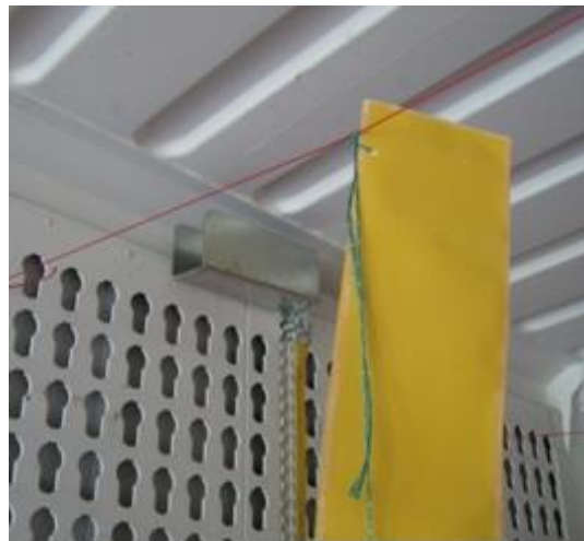
Abb. 29: Befestigung der Sensoren im WAB (Detailansicht).
