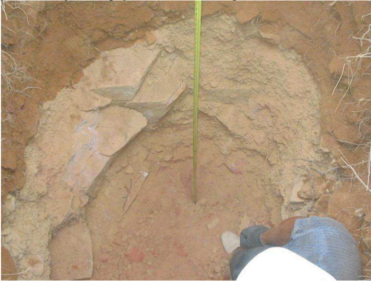
Figura 12 - Poço de inspeção com 3 metros de profundidade, Juazeiro/BA.
