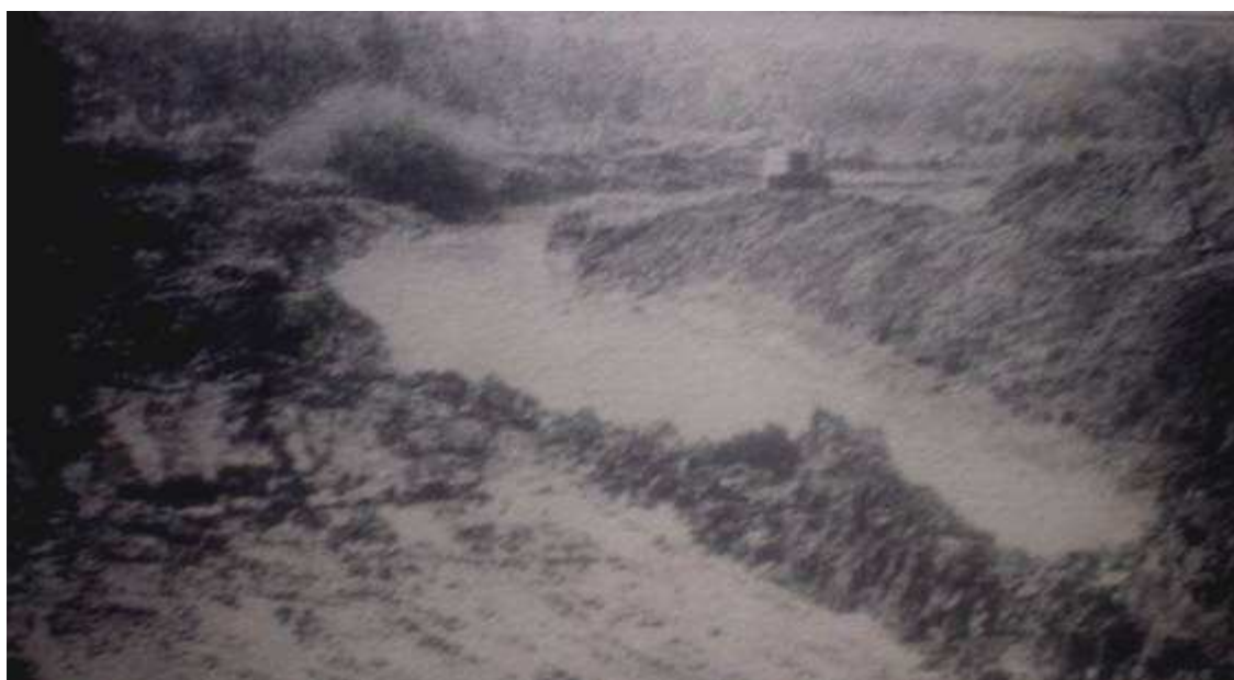
FIGURA 52 Arroio Castelhana - Braço artificial em fase adiantada de construção (1984)
