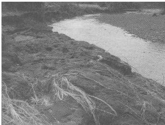
FIGURA 26 Arroio Castelhana - Erosão das margens e assoreamento do canal Fonte: Gazeta do Sul, 19 e 20 de julho de 2003.
