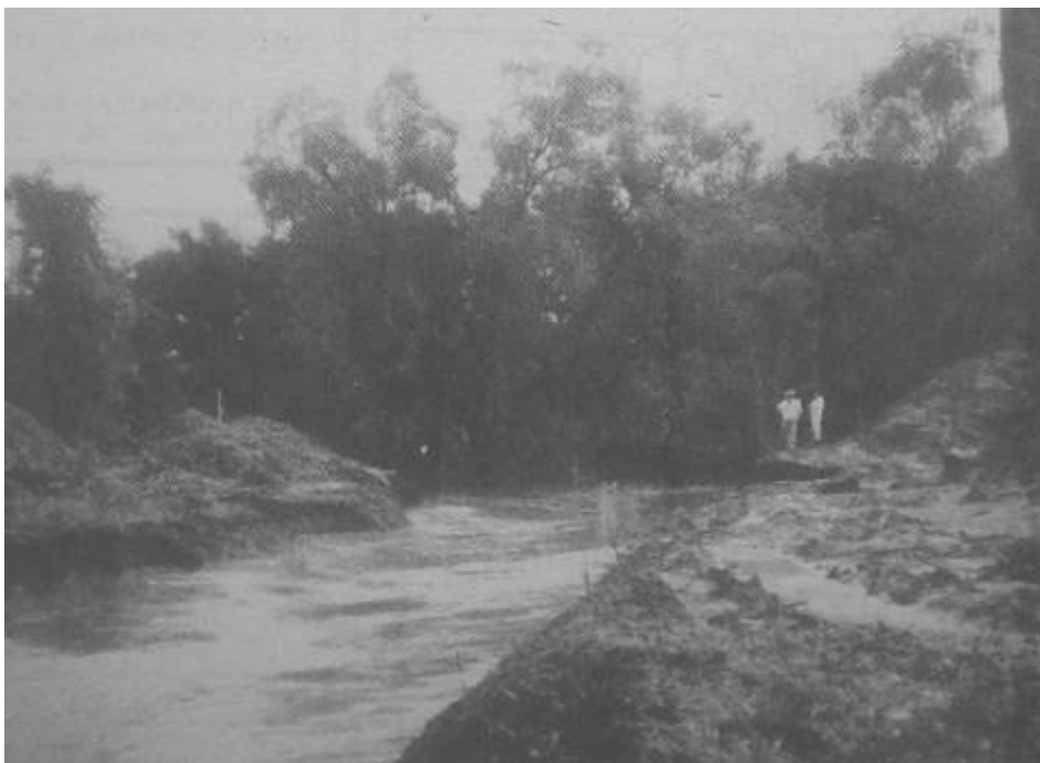
FIGURA 48 Arroio Castelhana retificado pelo Provárzeas (1987)
