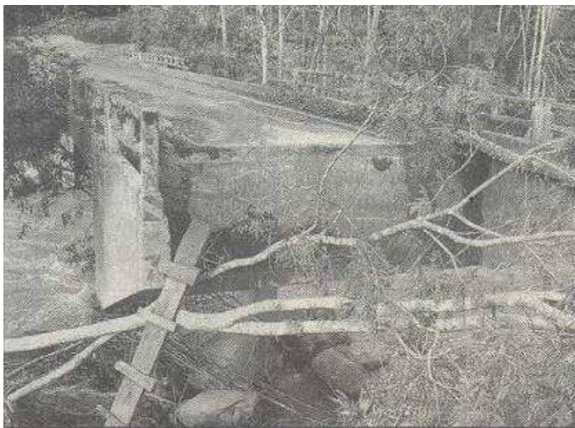
Arroio engoliu o aterro da ponte de Centro Linha Brasil
