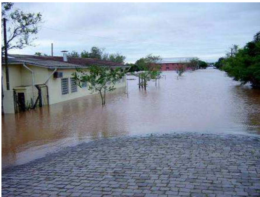
FIGURA 603 Rua do bairro União inundada em 9/07/2003
