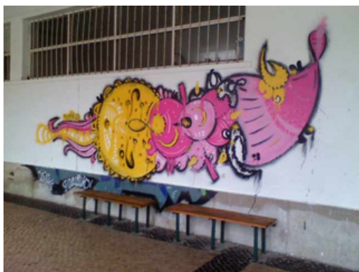
Figura nº 5 – Fotografia de graffiti no interior da escola (9º ano)
