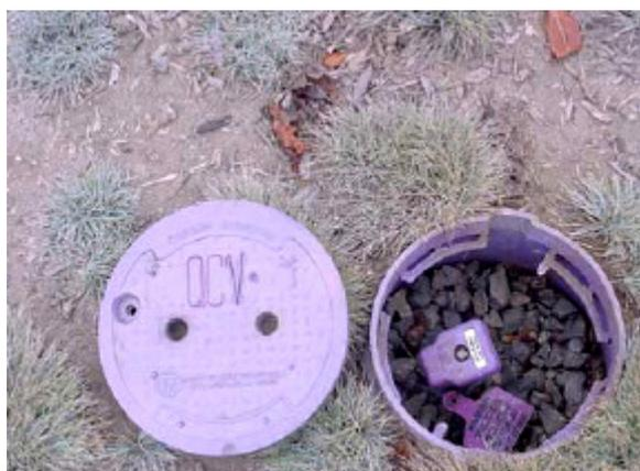
Fig.5.2 – Caixa de válvulas e ligação rápida identificada com etiqueta, ambas de cor roxa
