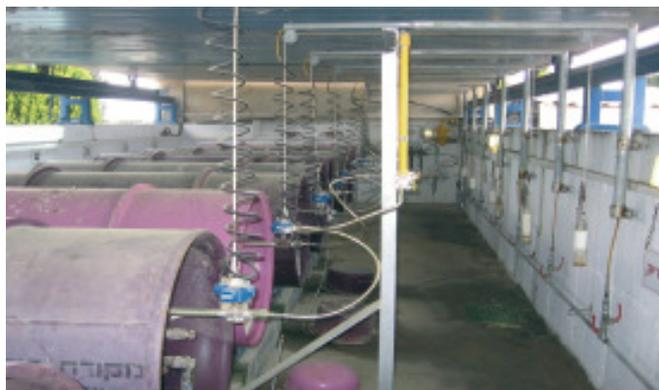
Fig.4.1 – Cilindros de cloro gasoso [18]
