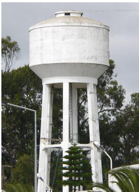
Fig.6.7 – Reservatório elevado no Feijó, com 100m<sup>3</sup> de capacidade
