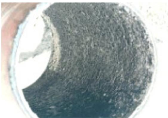
Fig.5.3 – Tubagem de fibrocimento para encaminhamento de ARUT, com biofilme acumulado durante 10 anos
