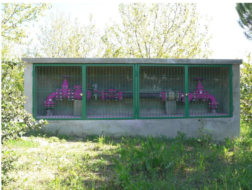
Fig.6.17 – Contador de água do Parque da Paz e válvulas de seccionamento (simulação das cores das válvulas, tubagem e contador de ARUT), com acesso permitido apenas a pessoas afectas aos serviços do Parque da Paz
