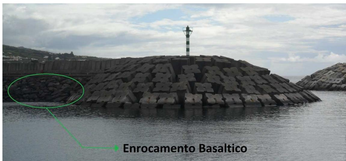
**Figura 53 - Utilização de enrocamento basáltico num molhe em Vila Franca do Campo - Ilha de S. Miguel, Açores.**
