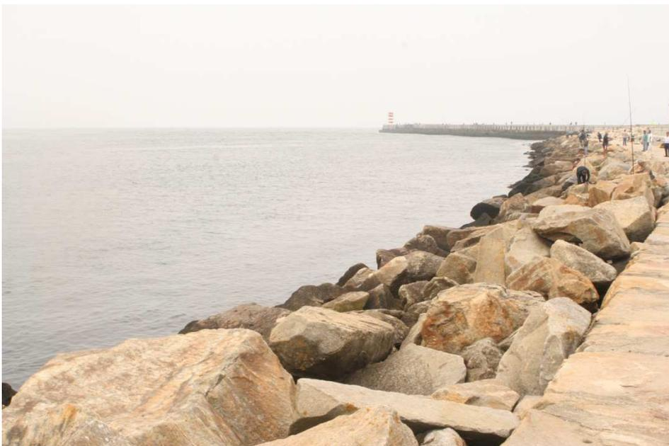
Figura 50 - Enrocamentos utilizados na margem norte dos molhes da Foz do rio Douro (Nuno Vasconcelos, 2012).
