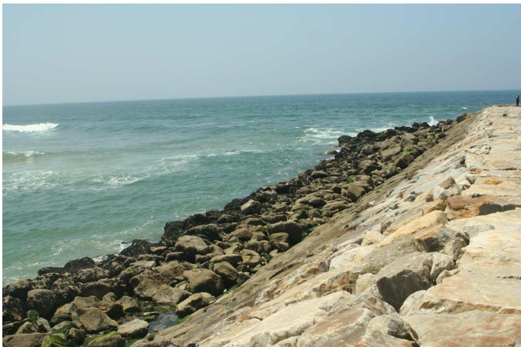
**Figura 51 - Os enrocamentos dos esporões estão sujeitos ao desgaste das fortes ondulações durante as tempestades de Inverno - Esporão de Cortegaça, Esmoriz (Nuno Vasconcelos, 2012).**
