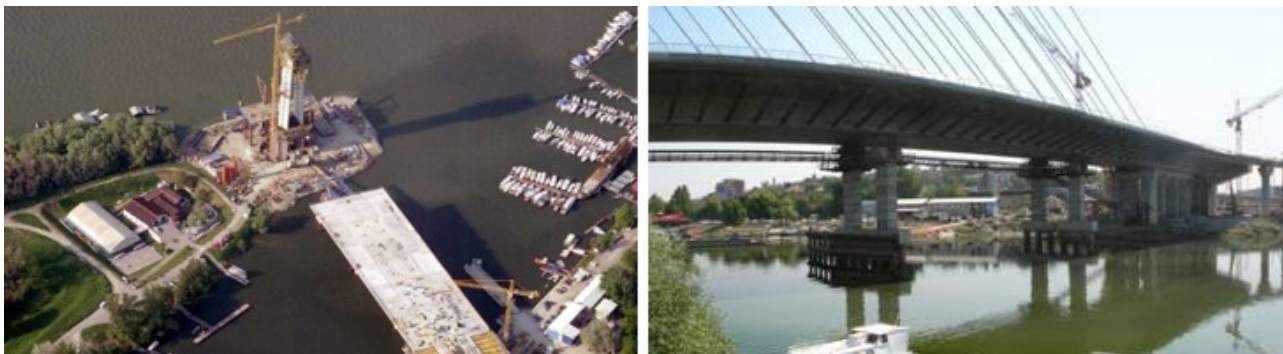
Slika 2. Izgradnja Mosta na Adi: platforma u podnožju pilona i privremeni stubovi na ulazu u Čukarički zaliv.
