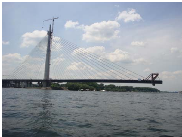
Slika 1. Most na Adi u toku izgradnje (maj 2011).
