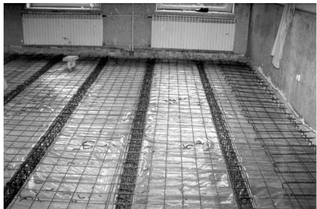
Slika 10. Izgled jedne od učionica neposredno pre betoniranja
