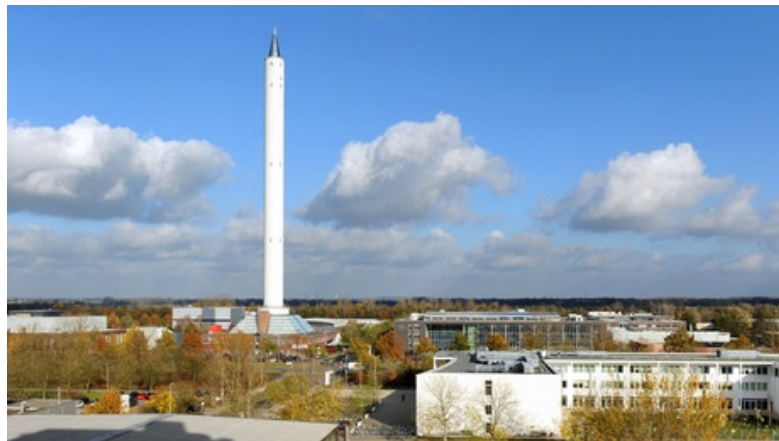
Abbildung 1.7.: Der Fallturm Bremen des Instituts ZARM eingebettet in den Campus der Universität Bremen. Der Fallturm hat eine Gesamthöhe von 146 m und bietet mit der 122 m langen Fallröhre im Inneren eine einzigartige Experimentumgebung unter Mikrogravitation. Die Restbeschleunigung in der evakuierten Röhre (auf 10 Pa) beträgt ein millionstel der Erdbeschleunigung, welche für 4,74 s genutzt werden kann. Diese Zeit kann mittels eines Katapults verdoppelt werden, wenn das Experiment diesen Betrieb zulässt.
