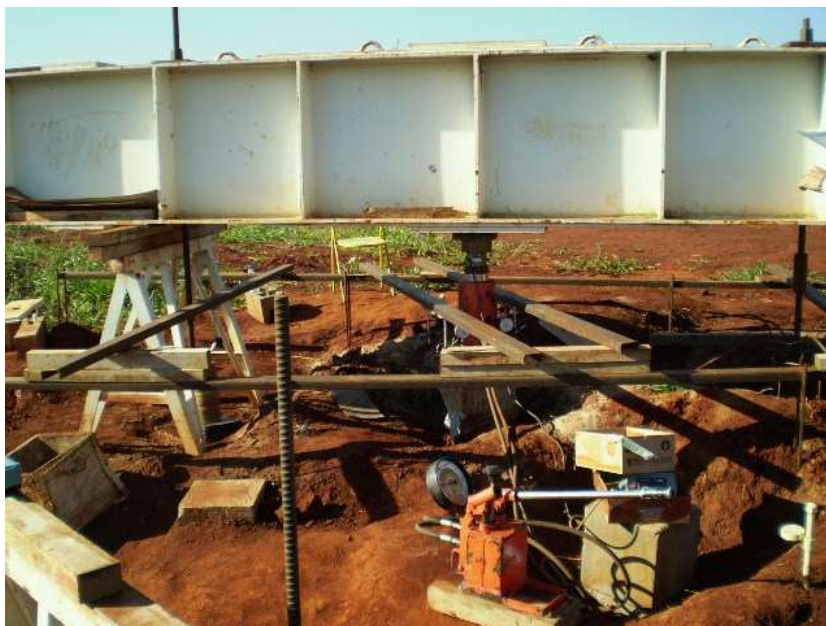
Figura 4.7. Prova de carga sem pré-inundação.
