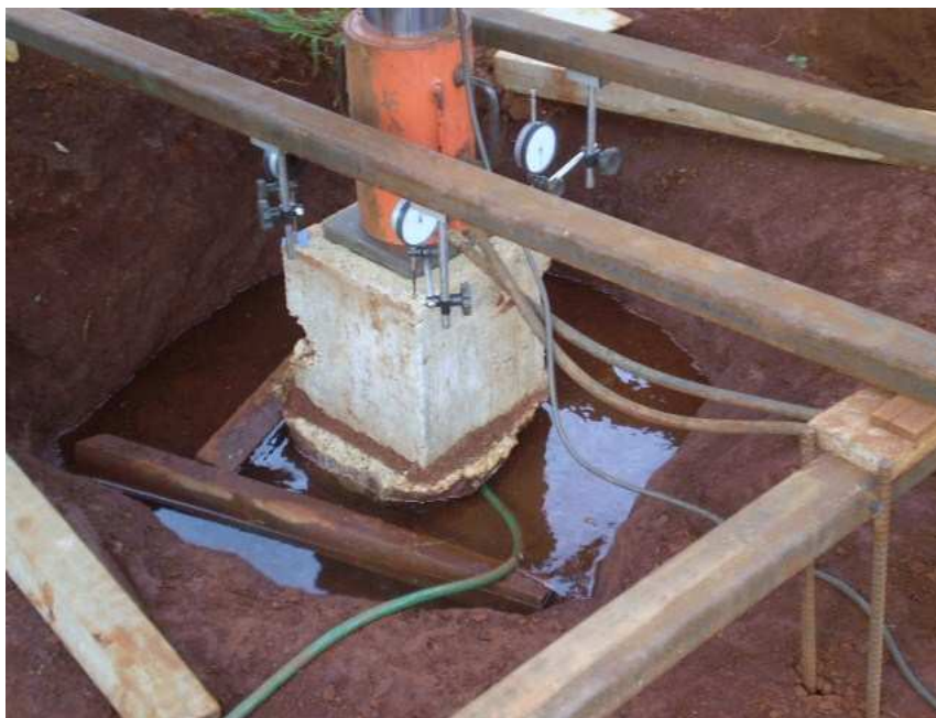
Figura 4.8. Prova de carga com pré-inundação.
