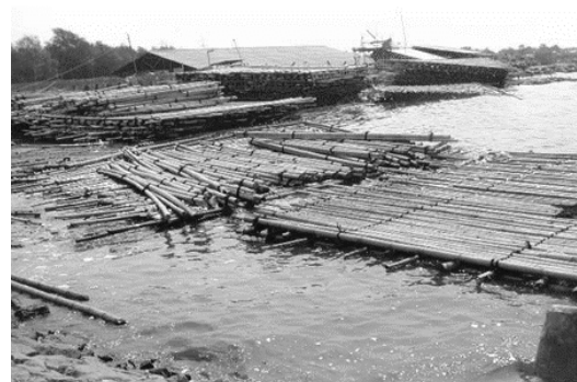
(b) Pemasangan matras bambu
