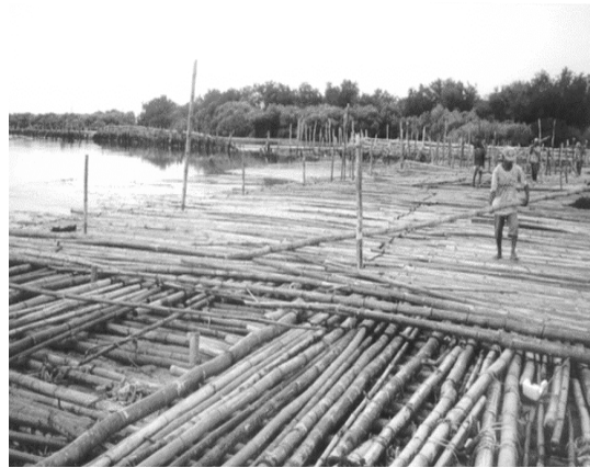
(b) Pemasangan matras bambu
