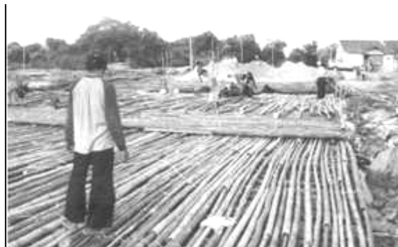
(c) Pemasangan Matras Bambu
