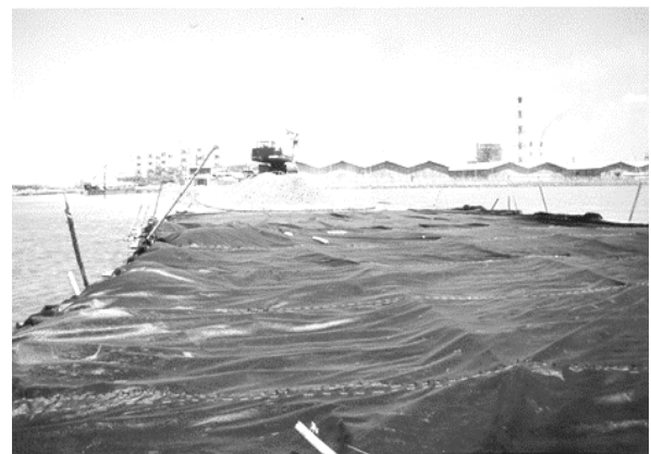
(b) Penghamparan geotextile di atas matras bambu
