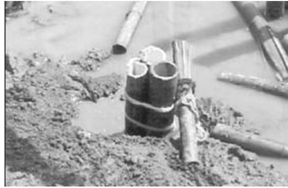
(b) Ikatan 3 Bambu untuk Struktur Cerucuk
