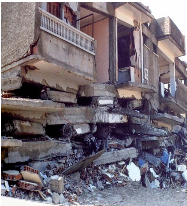
Figura 1.- Fallo frágil de un edificio.
