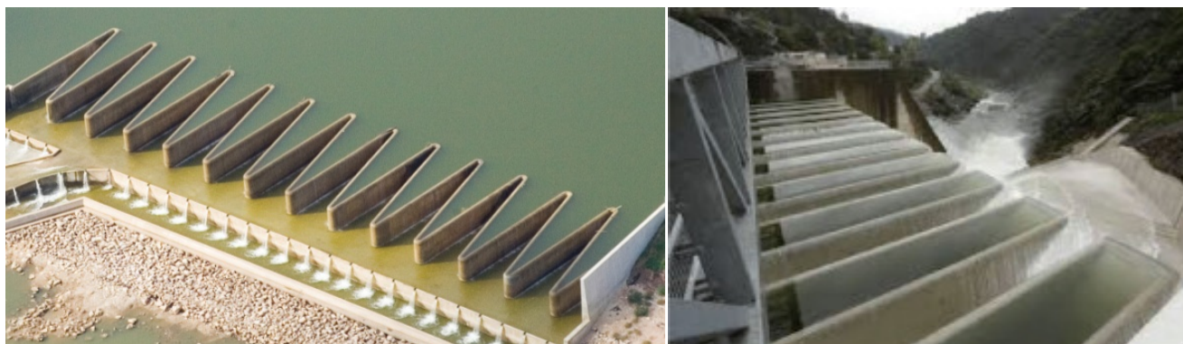
Figura 1 | Izquierda: aliviadero tipo laberinto en el lago Brazos, Texas, EE.UU (Fuente: Freese and Nichols, 2019). Derecha: aliviadero en tecla de piano en la presa de Malarce, Francia (Fuente: Lempérière, 2017 ).
