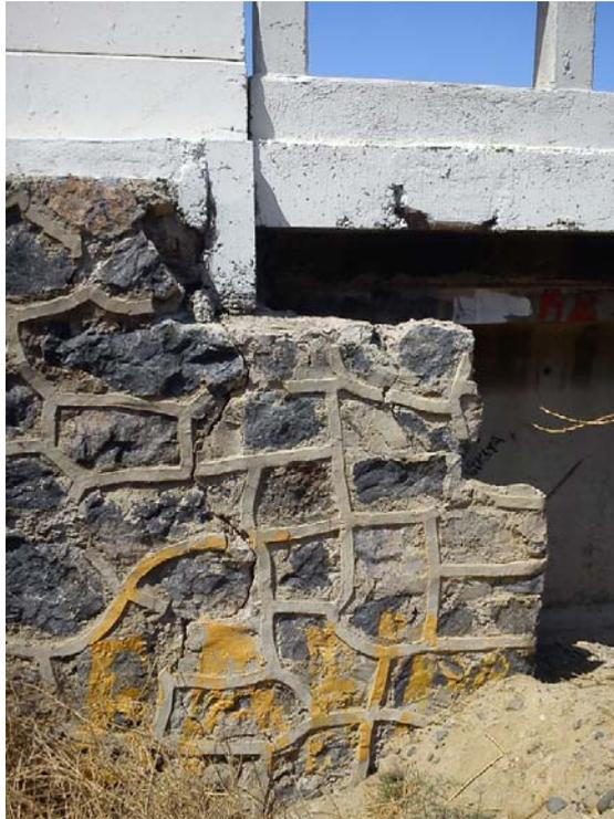
**Figura 8. Agrietamiento en estribo.**
