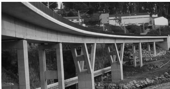
Figura 4.9 – Vista geral da ponte
