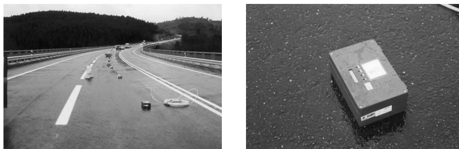
Figura 4.3 – Colocação dos sismógrafos sobre o tabuleiro durante o ensaio de vibração ambiental
