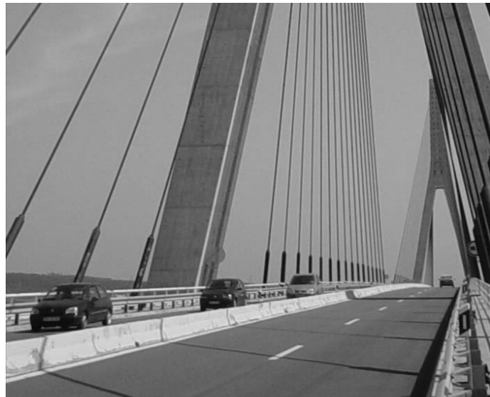
b) Ensaio de vibração ambiental da ponte sobre o Guadiana
