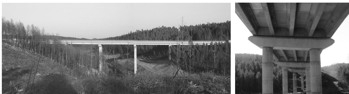
Figura 4.1 – Vista geral da ponte e vista inferior do tabuleiro.
